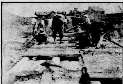
花河段優良河橋被水 冲毀正在修復情形
