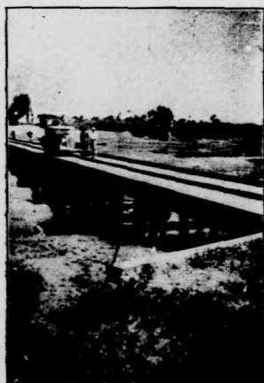
新建戴家灣大橋長八〇公尺 計十六孔
