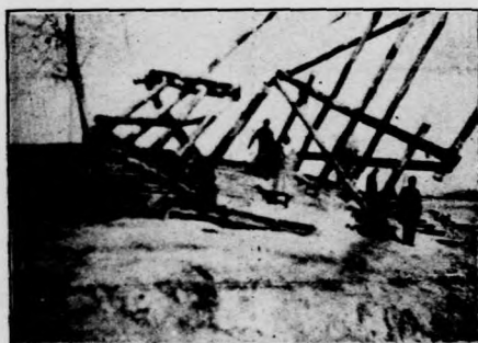
老白段聶家灘大橋被 冲情形
