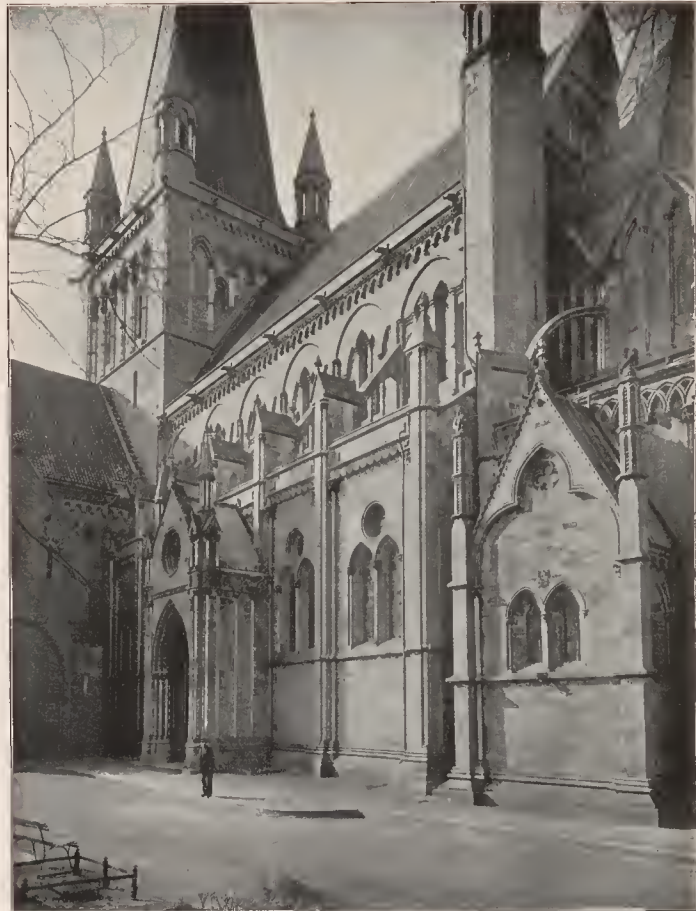
Korets ydre (sydsiden). Exterior of chancel (south side). — Das Äussere des Chores (die Südseite).
