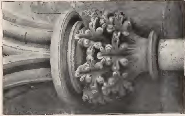
Kapitel fra vestre skib. Capital in the nave. — Kapitel im Westschiffe.
