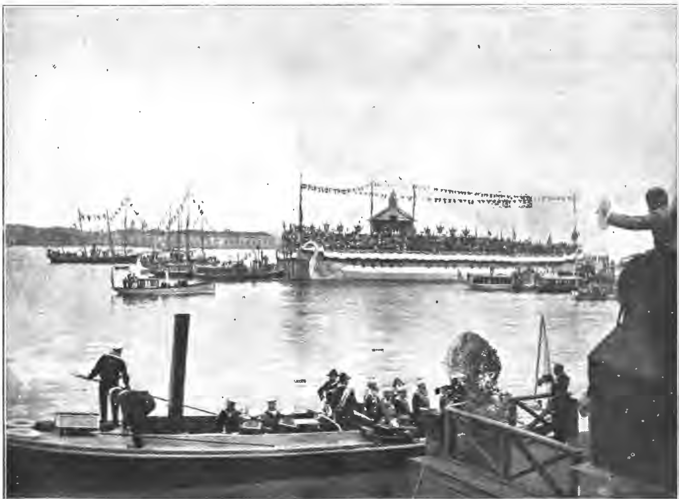
Торжество закладки новаго Троицкаго моста черезъ Неву. Отбытіе Государя Императора и Августѣйшихъ Особъ на паровомъ катерѣ отъ пристани у мѣста закладки. Съ фот. К. Булла, авторія „Нивы“.
