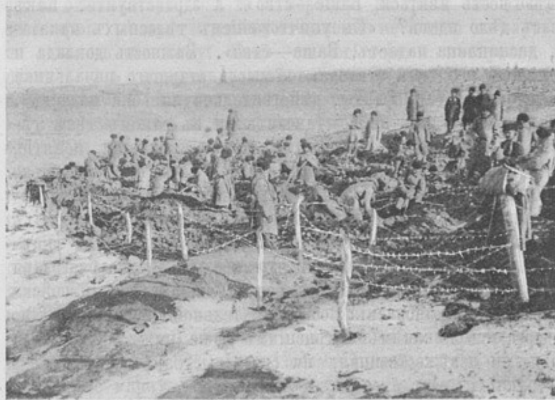
Устройство волчьихъ ямъ; впереди проволочныя загражденія. (Фотогр. Н. А. Хольмсенъ, собств. корресп.).
