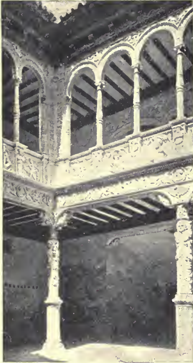
FIG. 203.—CASA DE ZAPORTA: COURTYARD.
