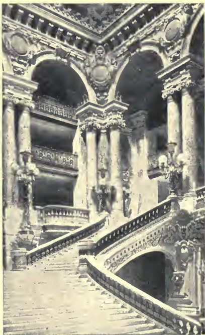
FIG. 215.—GRAND STAIRCASE OF THE OPÉRA, PARIS.
