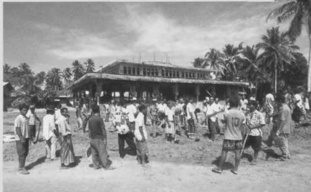
Masyarakat Aceh bergotong royong memperbaiki meunasah. Working together repairing a 'meunasah'.
