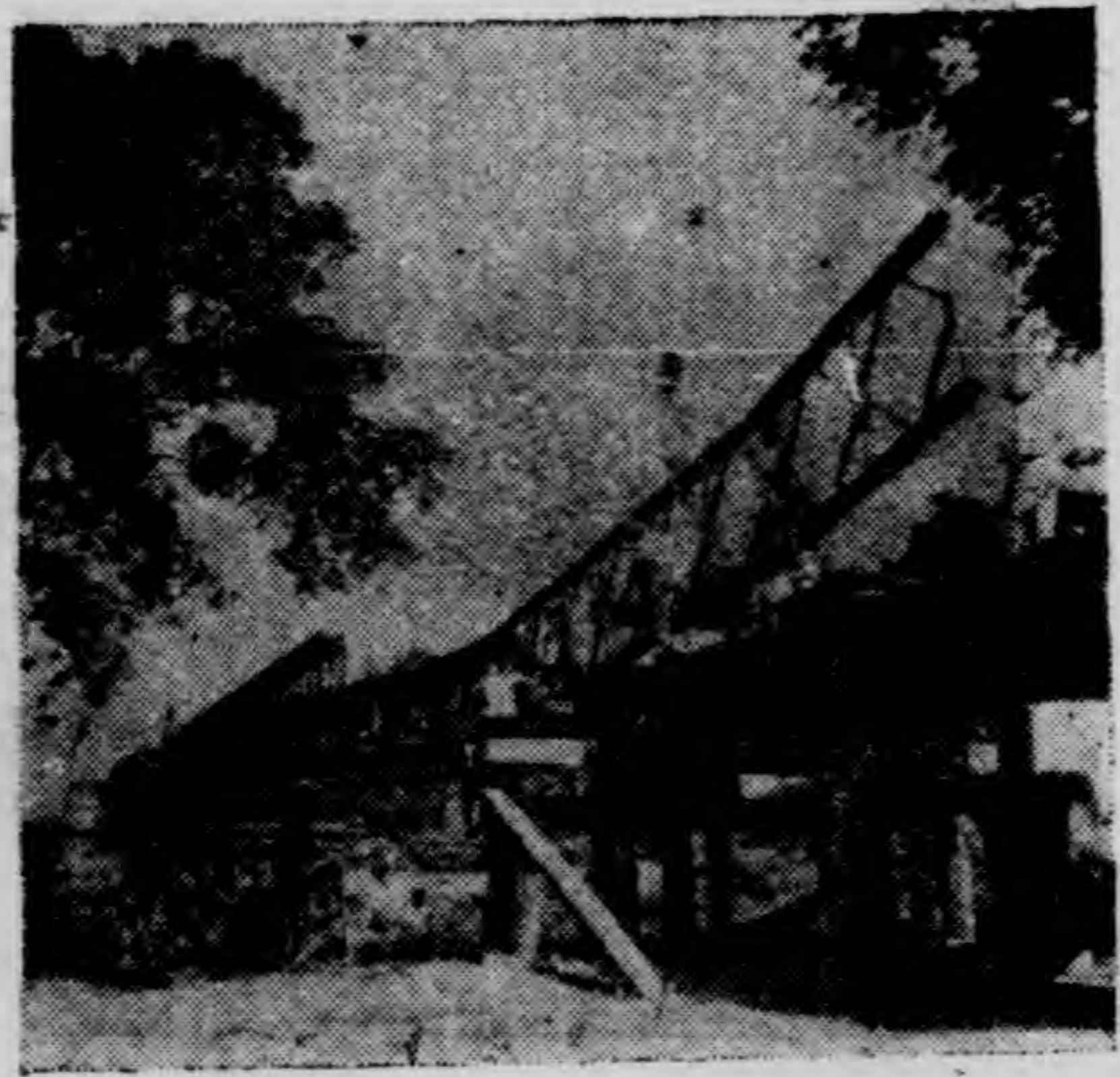
酒魯大橋全長百七十公尺為全 綫最大之橋圖為架橋時情形
