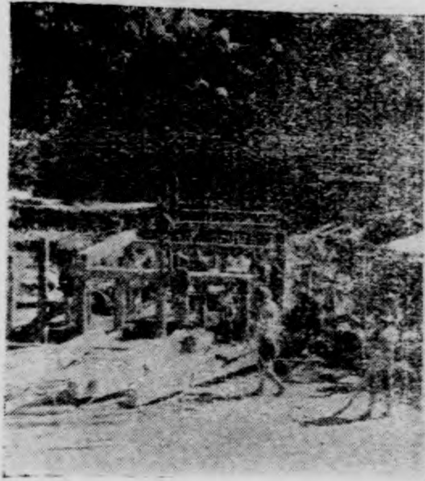
魯居大橋全部用硬木築成圖爲 架築時工作情形
