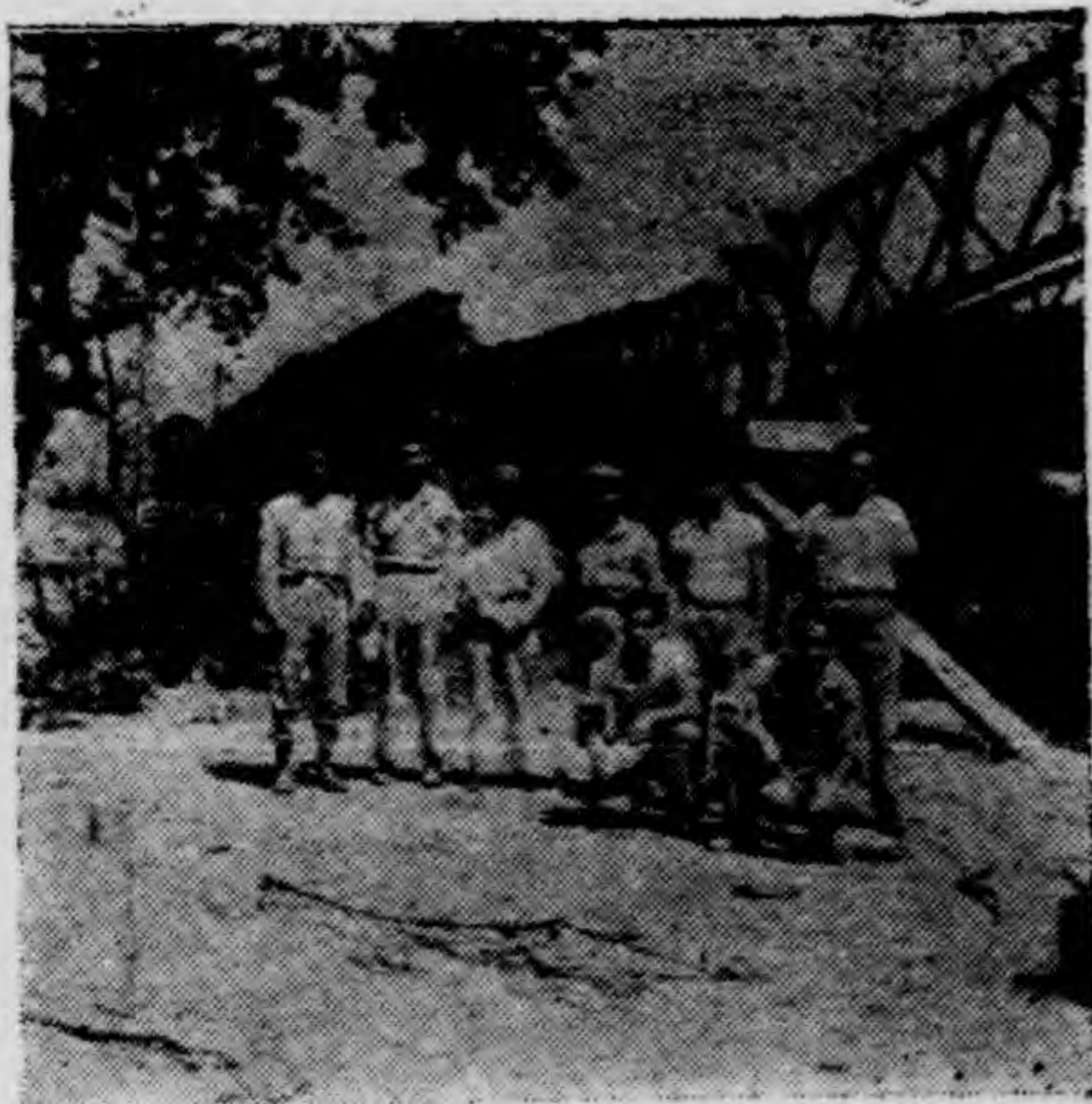
架橋工作完成後拆卸 Launching Nose 時情形
