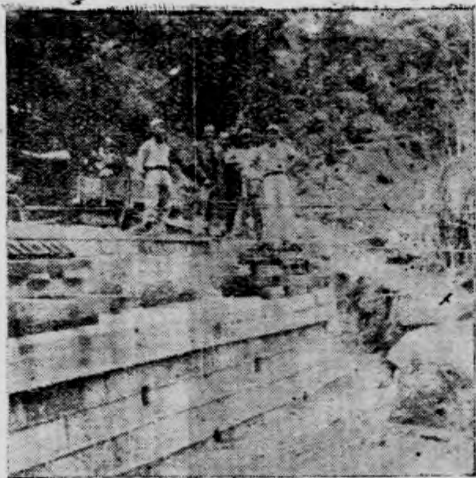
湯餅河橋爲一備壘式 (Bailey Type) 鋼橋橋台用細方石砌成頗爲美觀圖爲架橋情形之一
