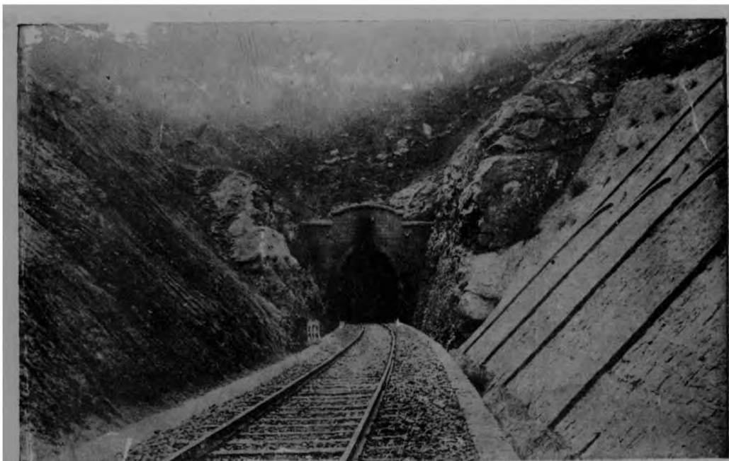
潼關穿城山洞（即十七號洞） 潼關爲通陝之孔道南倚羣山北枕黃河地屬險要 本路路線爲避免繞越羣山及河患計開鑿穿城山洞洞長千有八十公尺由東門迤南 數十武處穿城近南門處復出地面洞用人造石砌建觀牆爲本路第二長度之山洞
