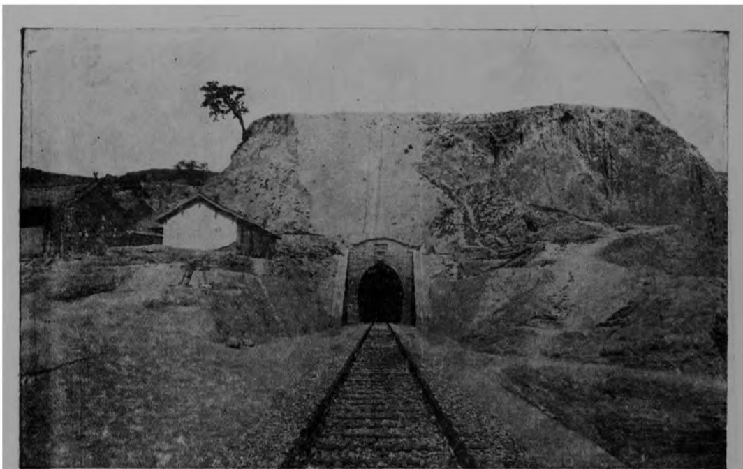
硤石山洞（即四號洞） 硤石古之崑陵也高峯連雲地勢險峻本路鑿山洞而通行 車洞長千七百七十九公尺有奇地質爲堅硬之岩層工程浩大爲國內最長之山洞亦 本路要工之一也
