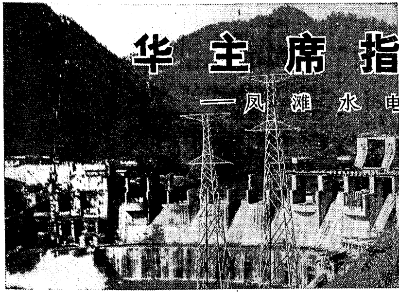
正在建设中的凤滩水电站全景。本报记者摄
