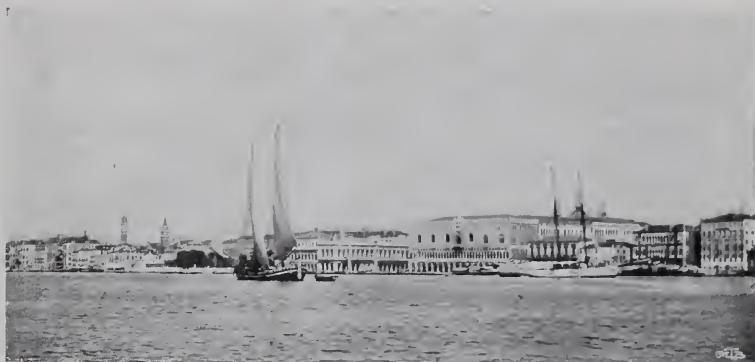
Dopo il crollo.
