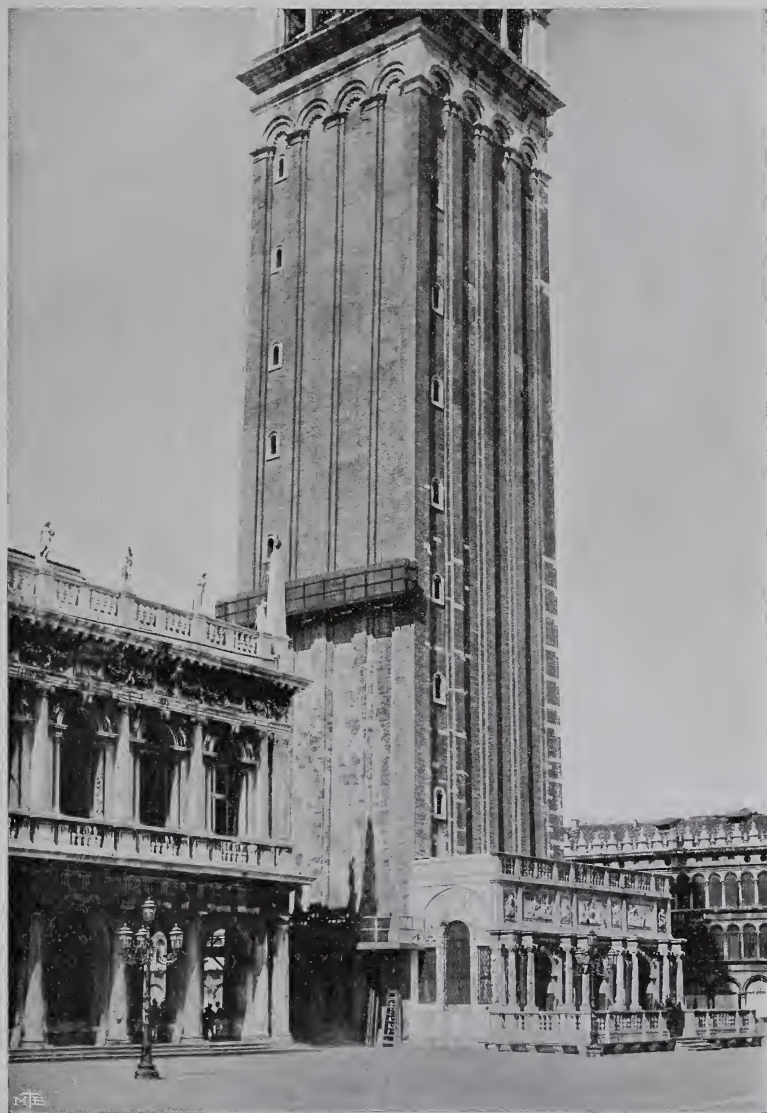
Fig. IX — L'operazione del «ripulimento» della parete sud-est del Campanile. (Al disotto del ponte di servizio, si notano ancora delle tratte del vecchio intonaco).
