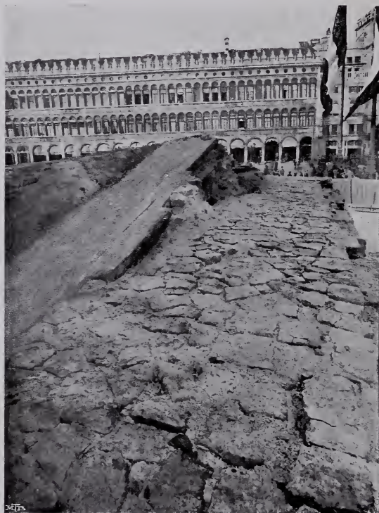
Fig. X — Veduta di uno dei corsi di mattoni romani in prossimità del basamento, e di una delle rampe.
