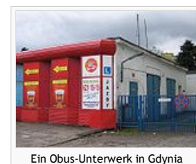
Ein Obus-Unterwerk in Gdynia
