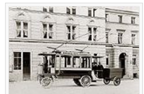
Die 1901 eröffnete Bielatalbahn war die erste Obuslinie Schiemanns. Gut erkennbar die hintereinander angeordneten Stangen unterschiedlicher Länge
