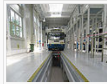
Gdynia: stationäre Wartungsbühnen im neuen Obus-Depot
