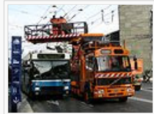
Luzern: Turmwagen bei der Reparatur einer Weiche
