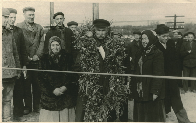
Відкриття залізо-бетонного мосту в м. Новомиргороді на Кіровоградщині через річку Велику Вись. 20 жовтня 1962 рік
