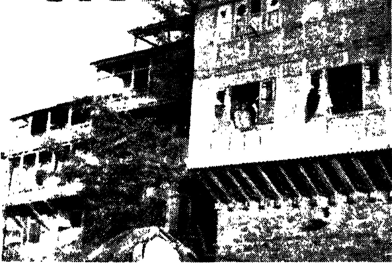
অধিকাংশ বাড়ীর নমুনা : প্রথম তলা পাথরের গাঁথনি, উপর তলা কাঠের ফ্রেমে ঢুকুরো ইটে ভরতি। টিনের ছাদ, পলেস্তারার বালাই নেই
