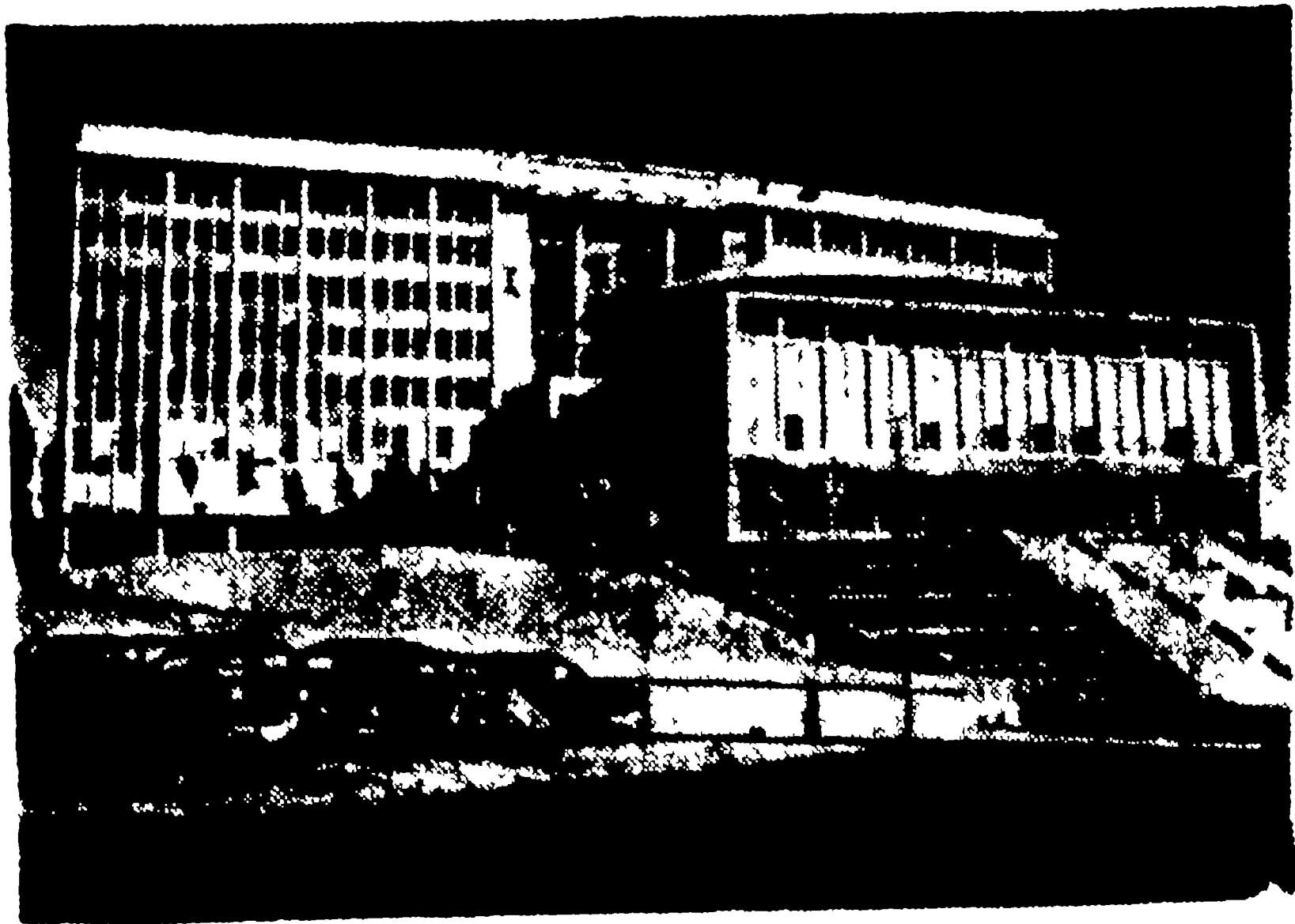
রাষ্ট্রপঞ্জের উদ্যোগে আফ্রিকা অর্থনীতি পরিকল্পনা কমিশনের প্রধান দপ্তর 'আফ্রিকা হল'। ইথিওপীয়ান সরকারের বদান্যতার নির্মিত এই ভবনে সম্প্রতি আফ্রিকার ত্রিশটি জাতির সম্মেলন বসেছিল
