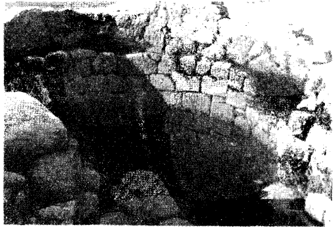
Sl. 2. OTVORENA CISTERNA U KASTAVSTINI
