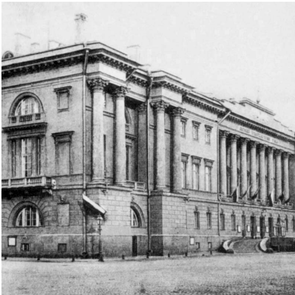
Ил. 40. Здание Святейшего правительствующего синода
