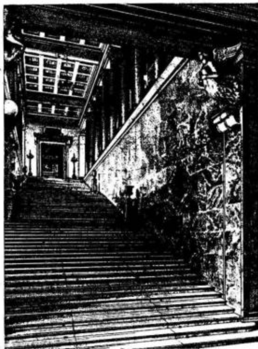
Лестница главного входа.
