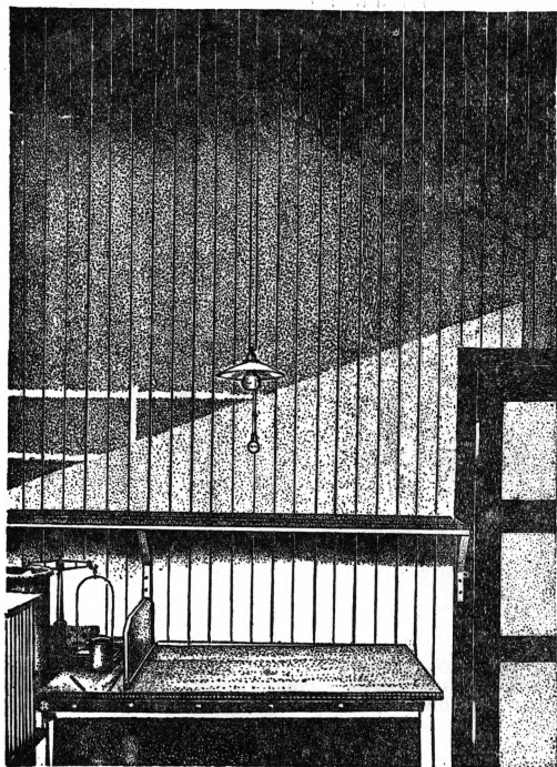
Рис. 6. Сверху стена окрашена цинковыми белилами, снизу—титановыми (после годичного срока).
