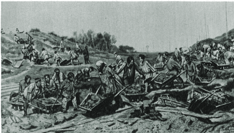
Савицкий К. А. Ремонтные работы на железной дороге. 1874. Гос. Третьяковская галерея. Москва.
