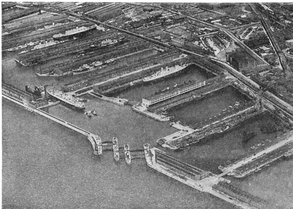
Ливерпуль, главный порт западной Англии. Часть доков Ливерпульского порта, вмещающих величайшие океанские суда. На первом плане — шлюзовые ворота, позволяющие сохранять уровень воды в бассейнах во время отлива.
