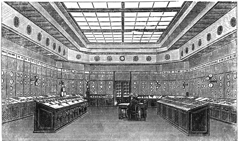
Рис. 10. Щит управления МОГЭС.
