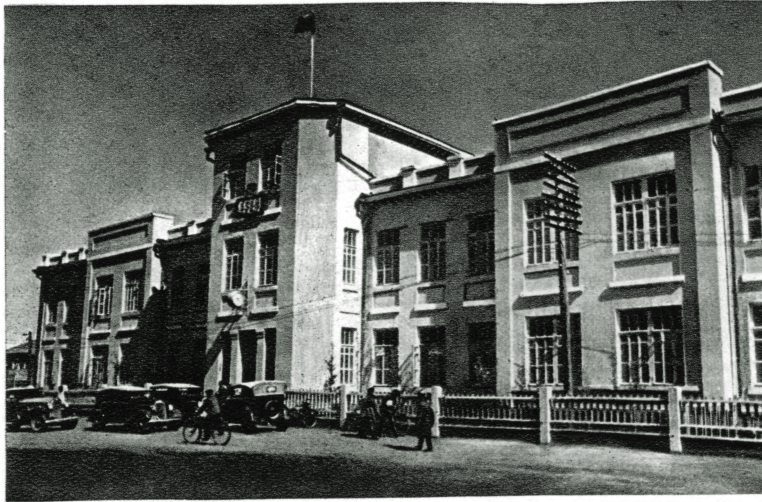
Здание правительства МНР в г. Улан-Баторе.
