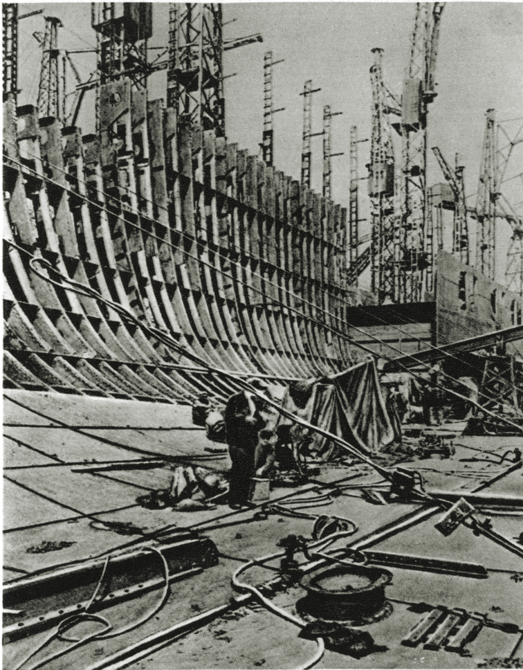
Рис. 17. Сборка бортового набора. Настилка второго дна.
