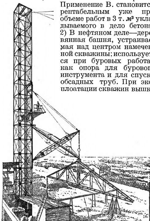
Железная вышка для работ с литым бетоном.
