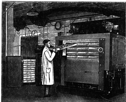
Рис. 4. Скороморозилка системы Бердзая.
