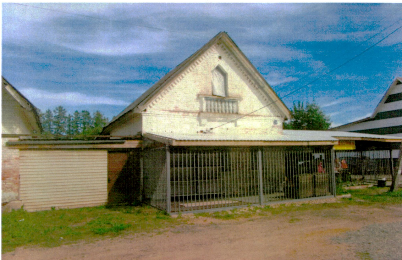
5. Общий вид с юго-запада.
