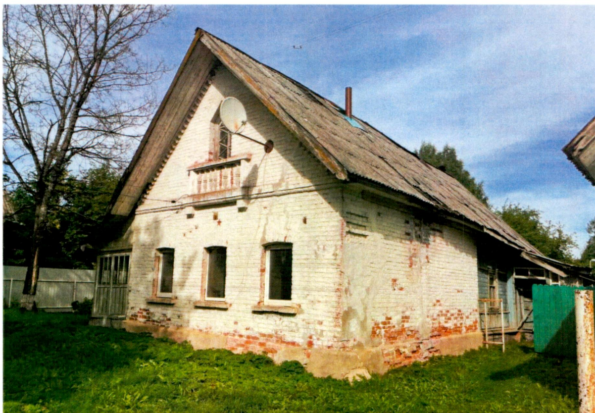
1. Вид с юго-запада.
