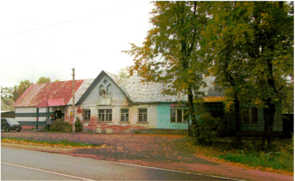
7. Общий вид. Западный фасад.
