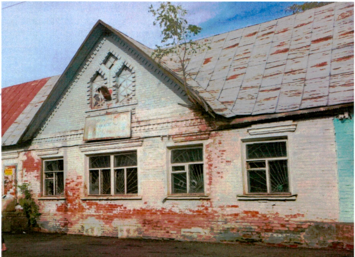
8. Центральная часть западного фасада.
