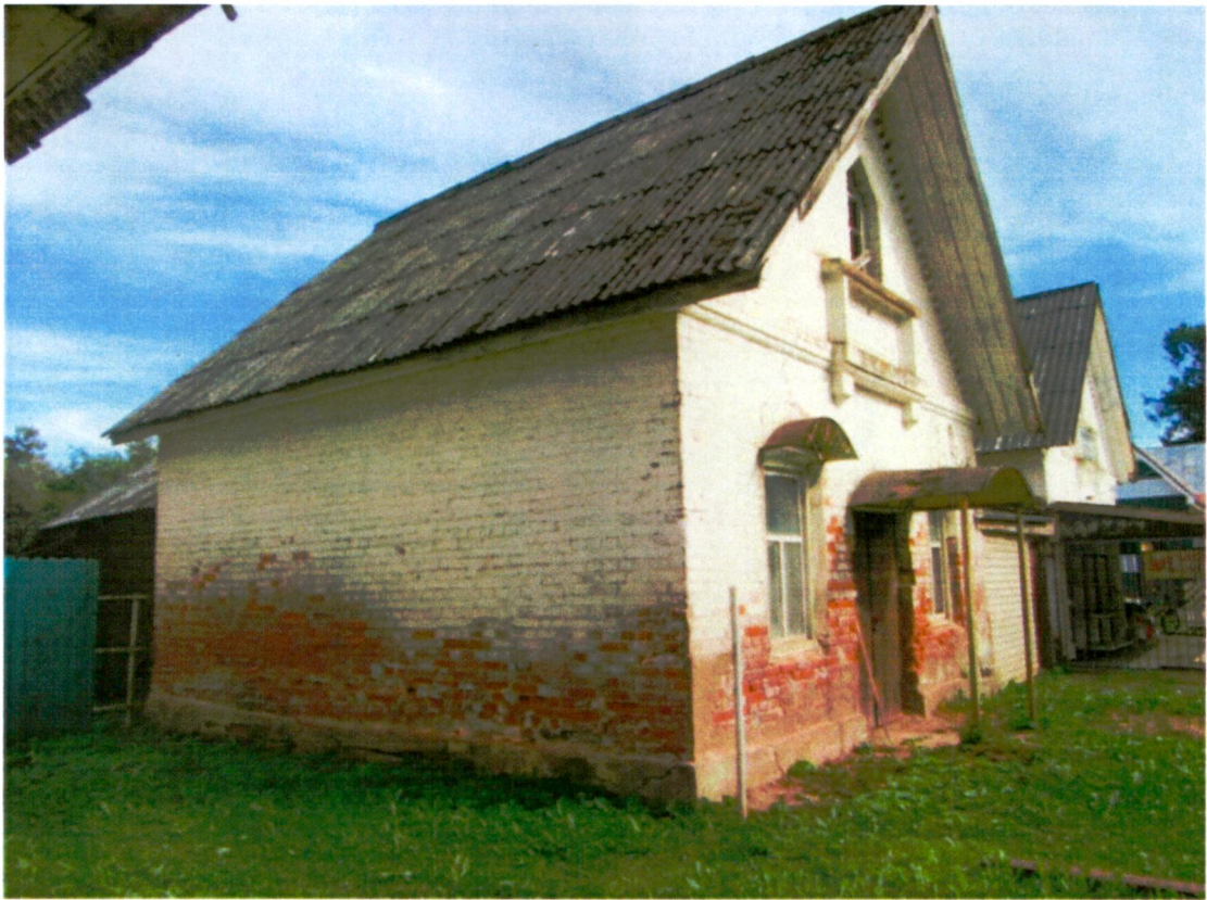
3. Общий вид с северо-запада.
