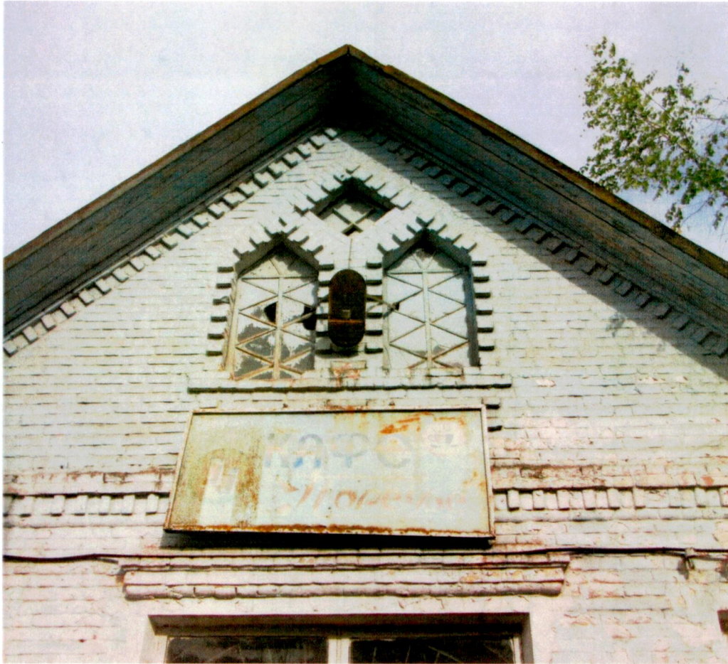
9. Чердачные окна и завершение центральной части западного фасада.
