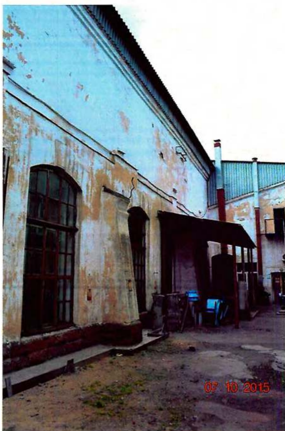
Фото 4. Северный фасад. Фрагмент.
