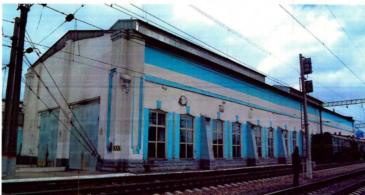
Фото 2. Общий вид с запада.
