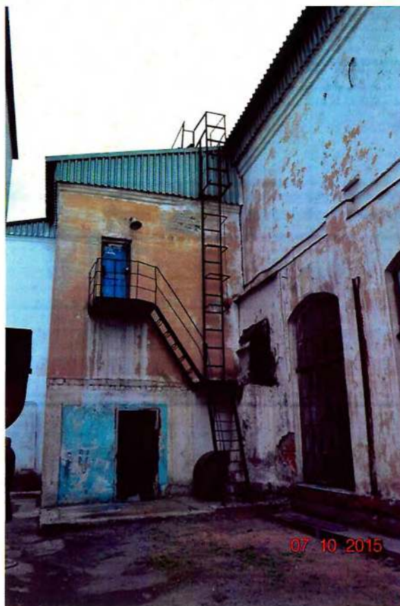
Фото 5. Северный фасад. Фрагмент.
