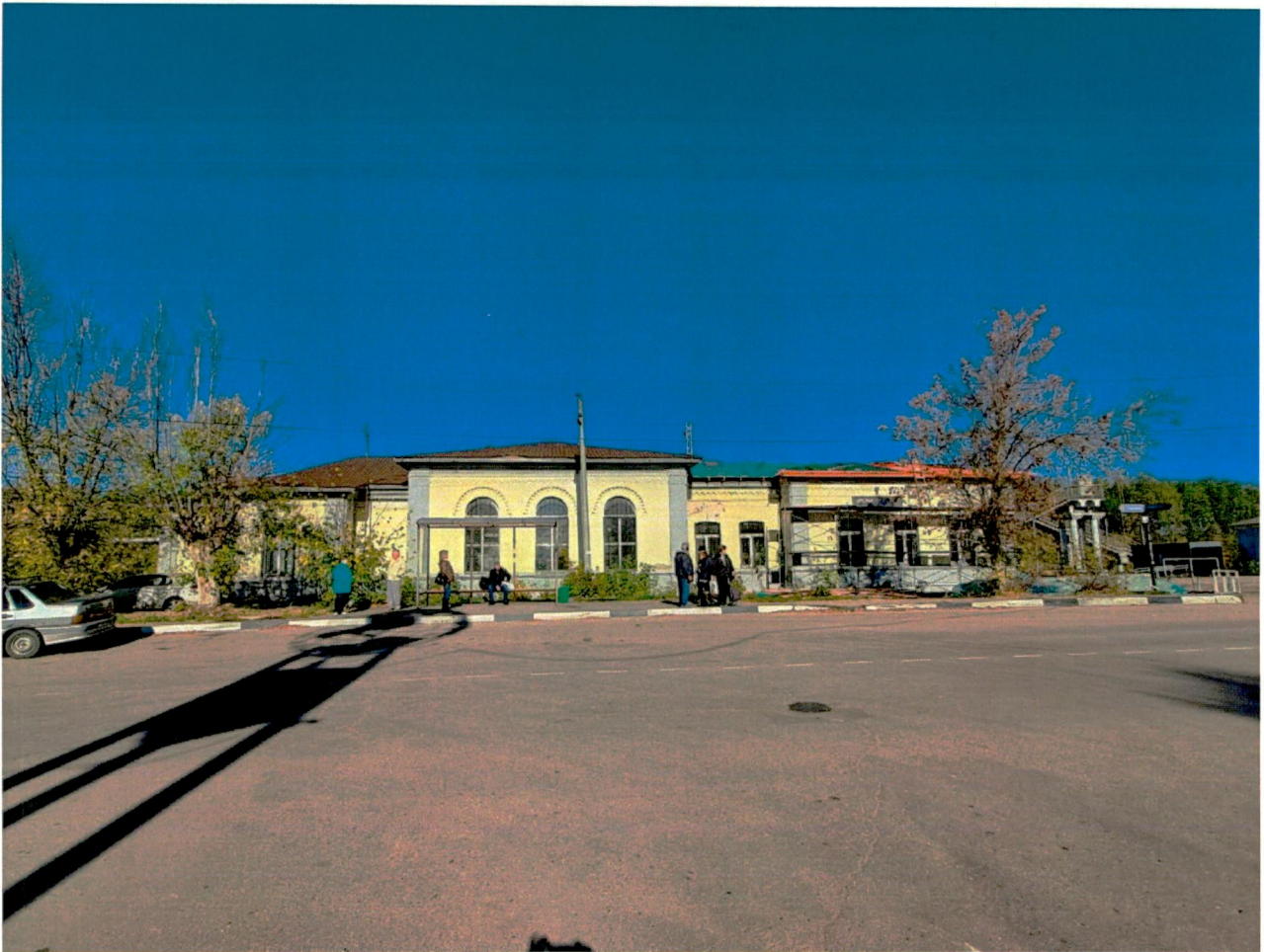
4. Вид на южный фасад с улицы Революции г. Дрезна
