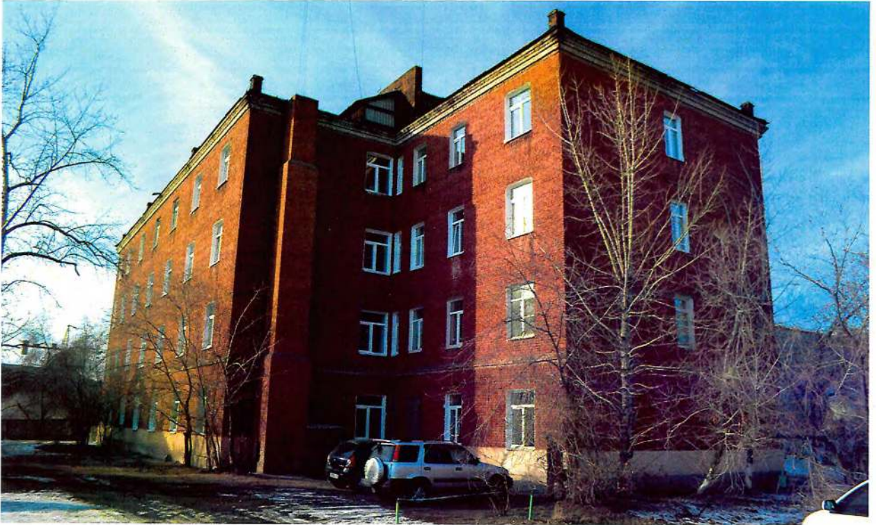
Фото 3. Дворовый южный и восточный торцевой фасады.
