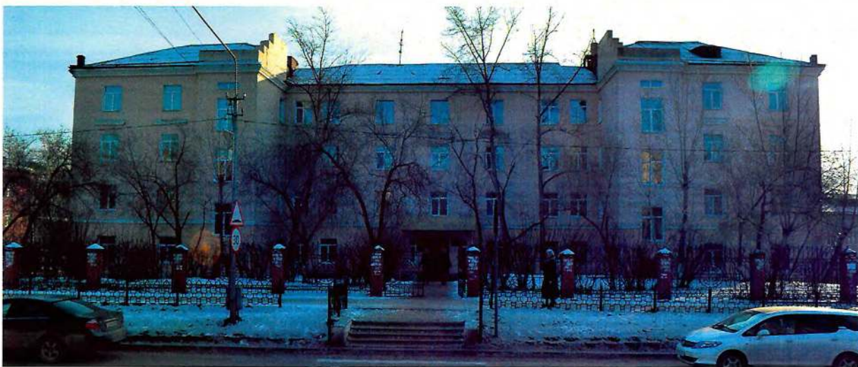
Фото 1. Общий вид с севера.
