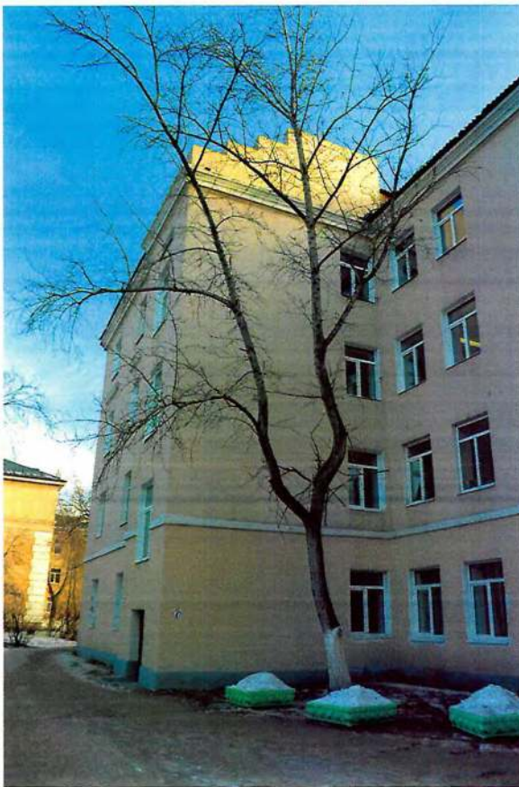
Фото 6. Фрагмент главного фасада.
