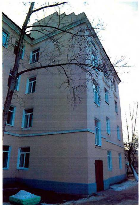
Фото 7. Фрагмент главного фасада.
