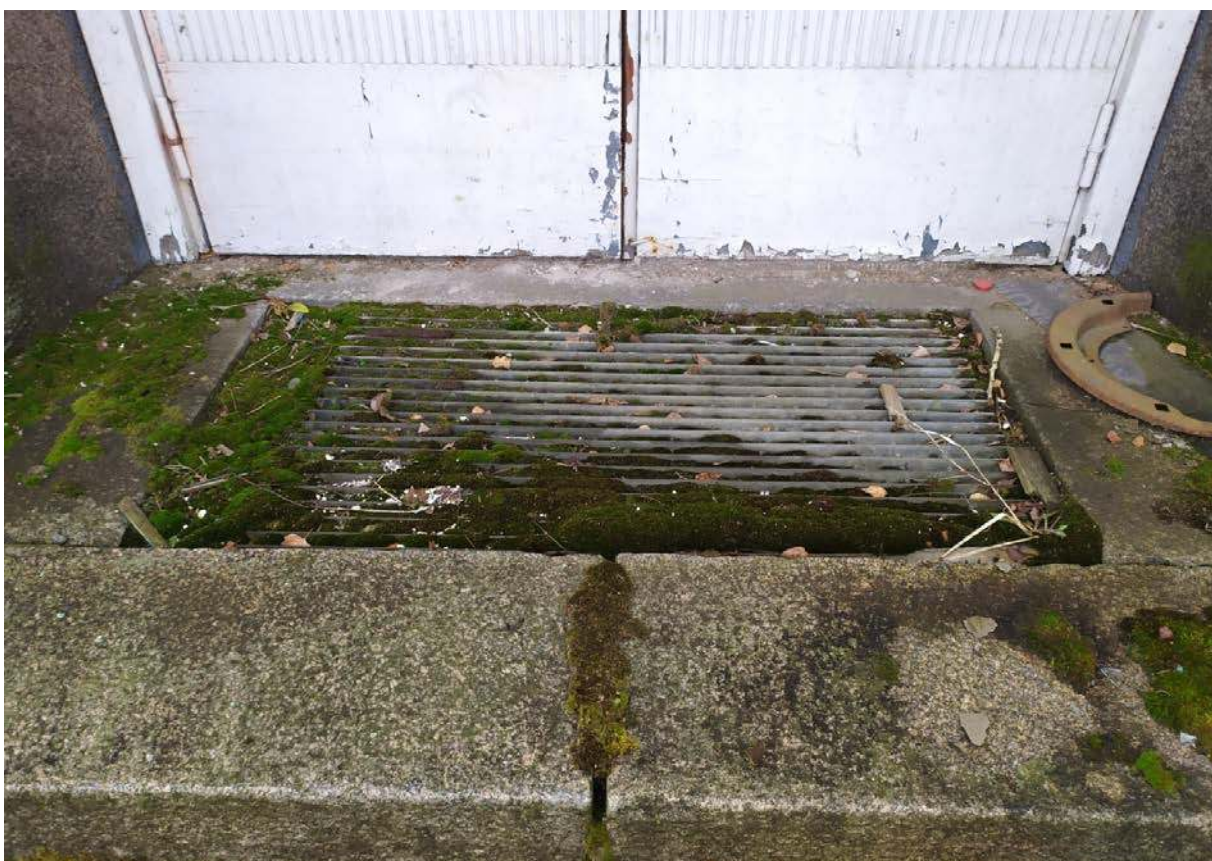
9. Восточный фасад здания. Входная группа, облицованная блоками финского серого гранита.
