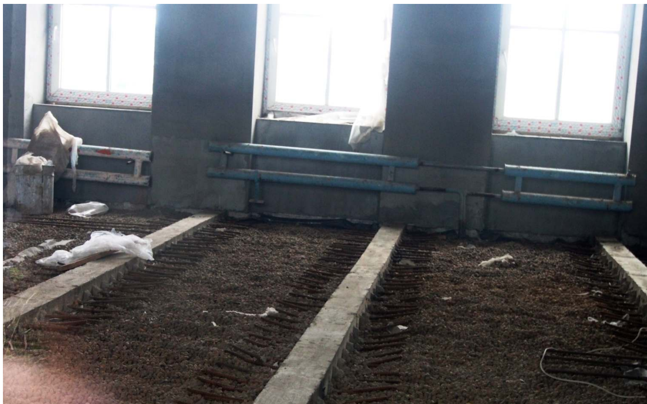
15. Интерьер. Помещение первого этажа.
