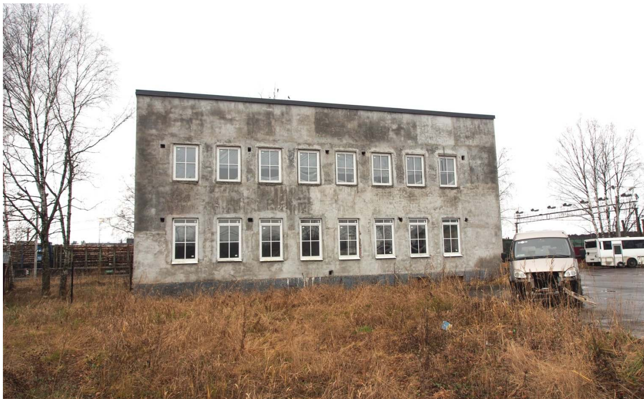
6. Восточный фасад здания.
