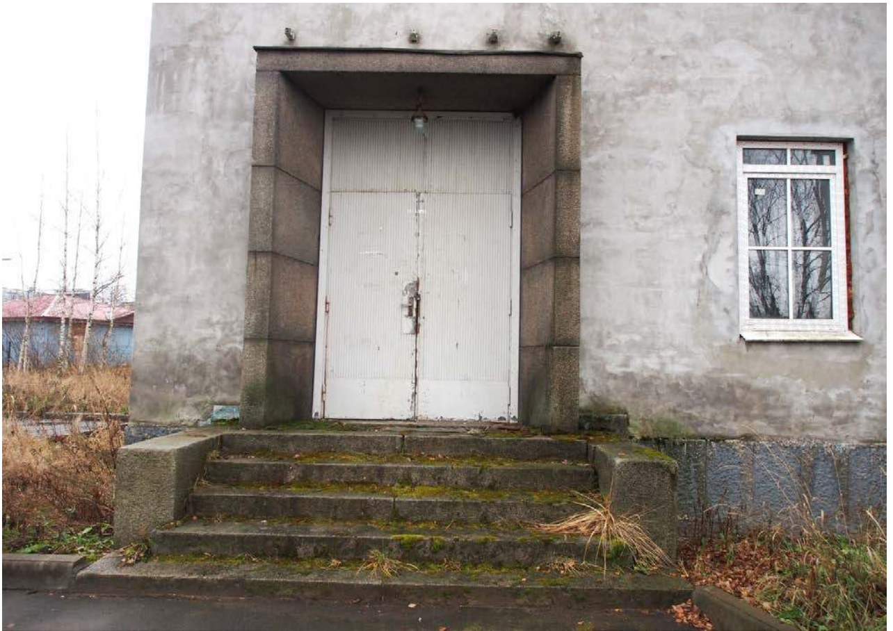
7. Восточный фасад здания. Входная группа, облицованная блоками финского серого гранита.
