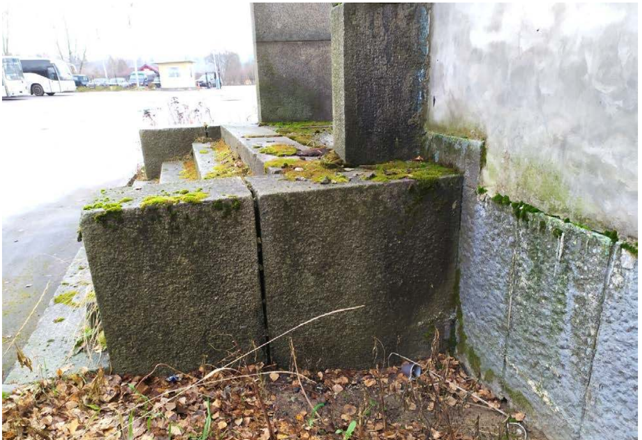
8. Восточный фасад здания. Входная группа, облицованная блоками финского серого гранита.
