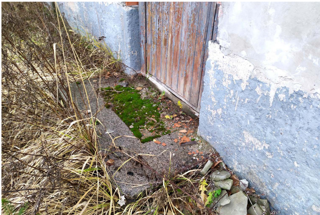
12. Фрагмент южного фасада.
