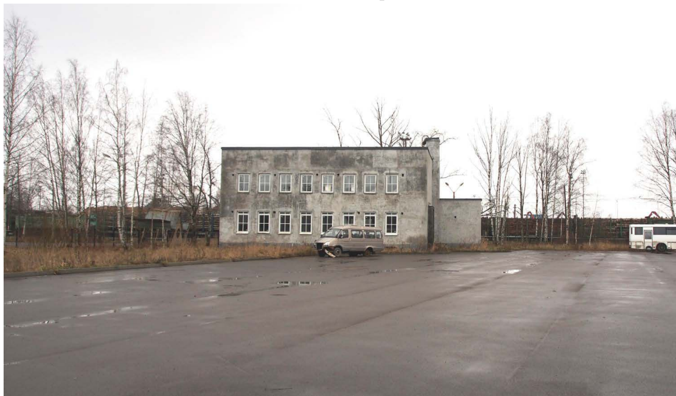
1. Общий вид здания с северо-востока.
