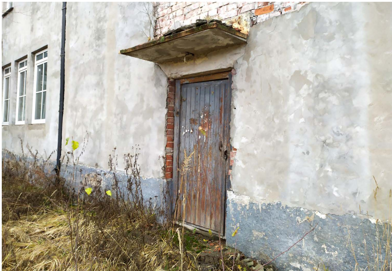
11. Фрагмент южного фасада.
