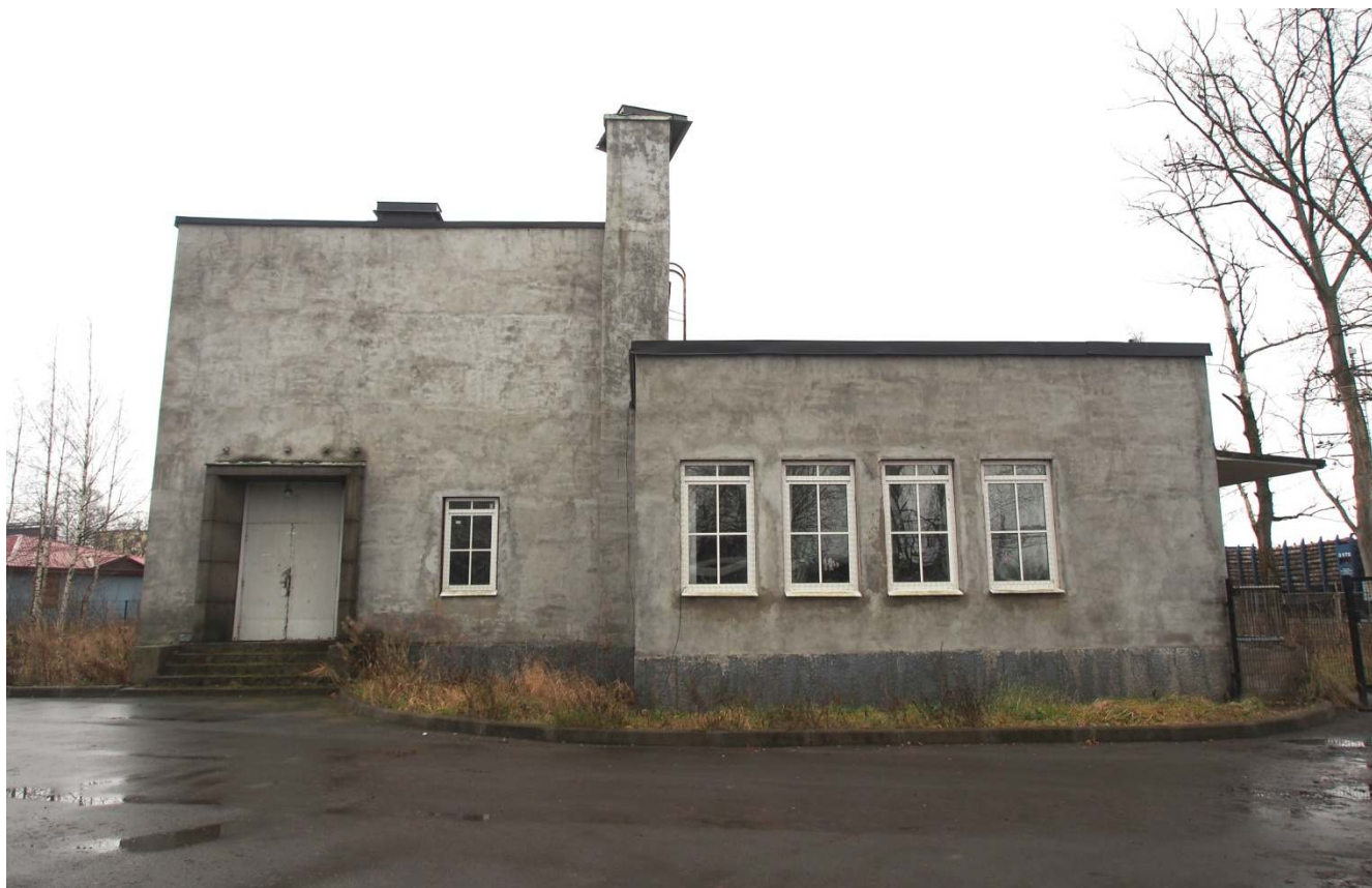
3. Северо-западный фасад здания.
