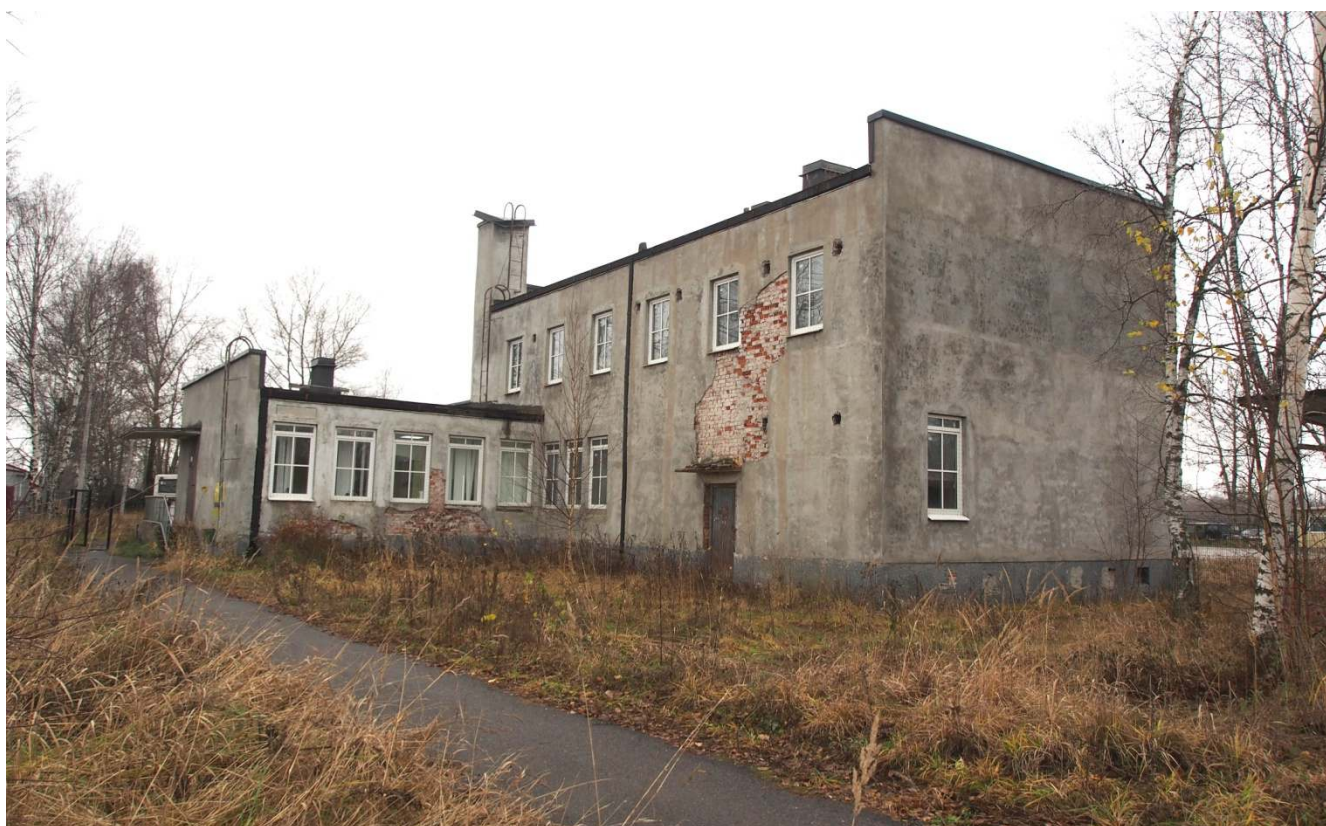
4. Общий вид здания с юга.
