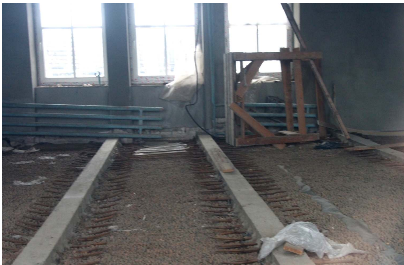
16. Интерьер. Помещение первого этажа.
