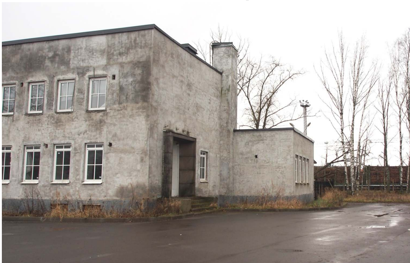
2. Вид здания с севера.
