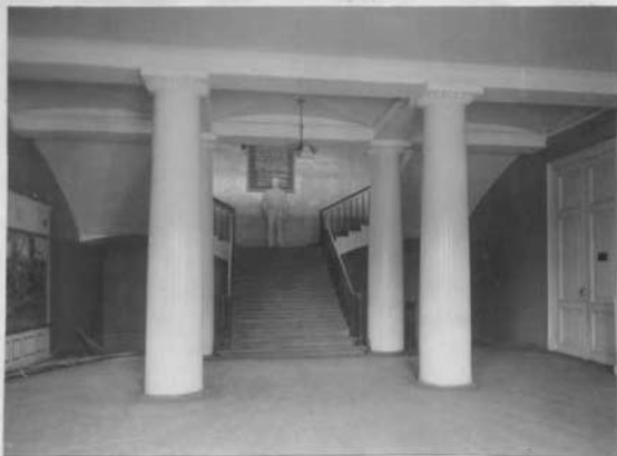
Главная лестница. 2-й этаж.
