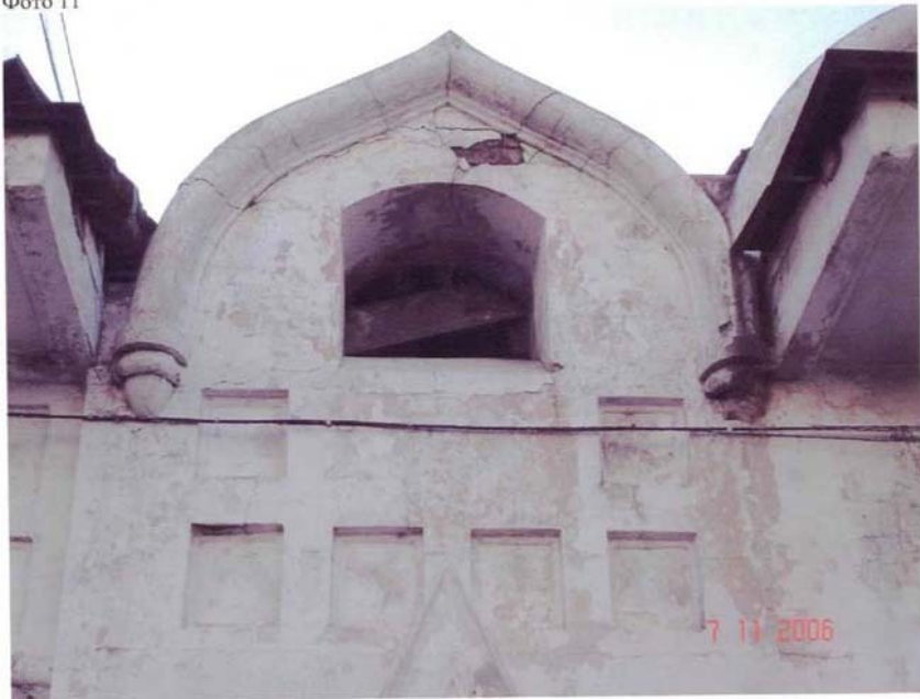
г. Хабаровск, ул. Кавказская, 35 Рефрижератор, 1913г., 1925г., 1928 г.. Фрагмент главного, северо-восточного фасада.
