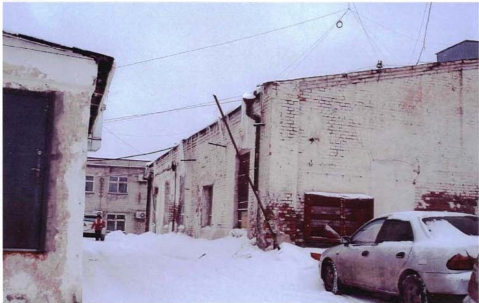
г. Хабаровск, ул. Кавказская, 35 Рефрижератор, 1913г., 1925г., 1928 г.. Юго-западный фасад, центральная часть.
