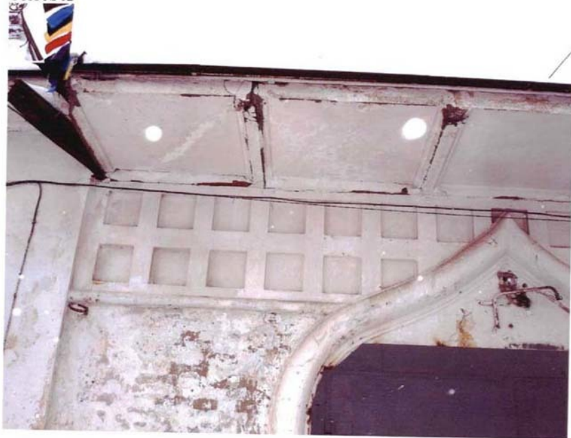
г. Хабаровск, ул. Кавказская, 35 Рефрижератор, 1913г., 1925г., 1928 г.. Главный, северо-восточный фасад, левая западающая часть.
