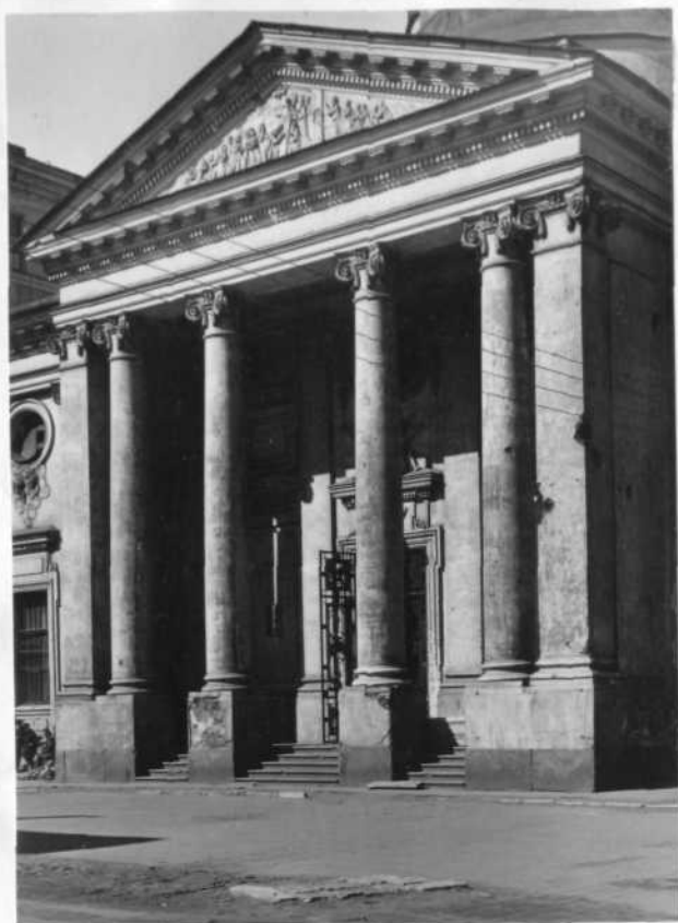
Центральная часть южного фасада Петр. Павл.
