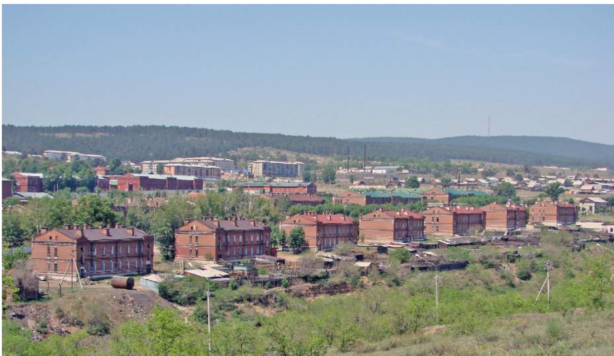
Фото 1. Общий вид ансамбля. Вид с востока.
