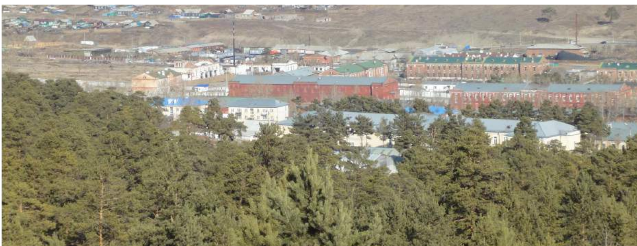
Фото 2. Общий вид ансамбля. Вид с севера.
