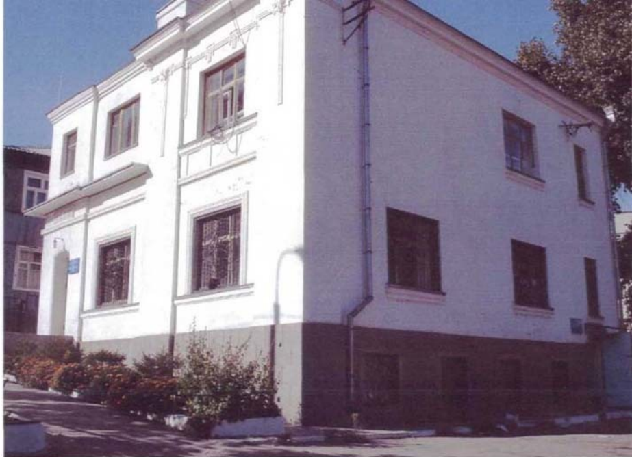
г. Хабаровск, ул. Кавказская, 22. Дом жилой Д.А. Языкова, до 1912. Вид с юго-восточной стороны
