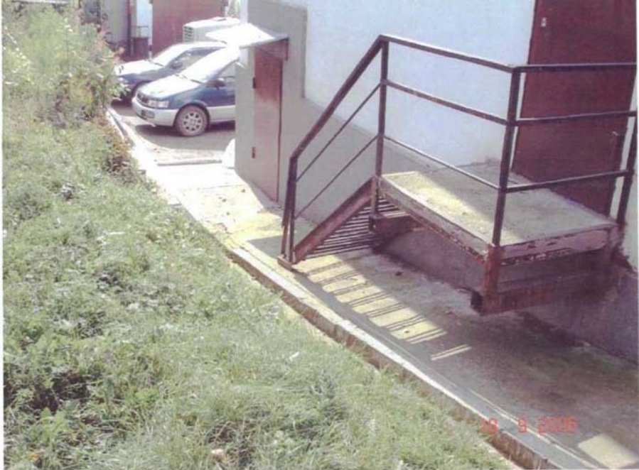
г. Хабаровск, ул. Кавказская, 22. Дом жилой Д.А. Языкова, до 1912. Фрагмент северо-восточного фасада
