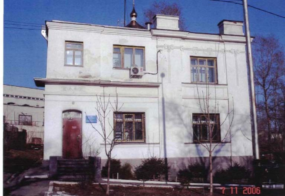
г. Хабаровск, ул. Кавказская, 22. Дом жилой Д.А.Языкова, до 1912. Главный, юго-западный фасад. Фото Дыминской А.В. 2006 г
