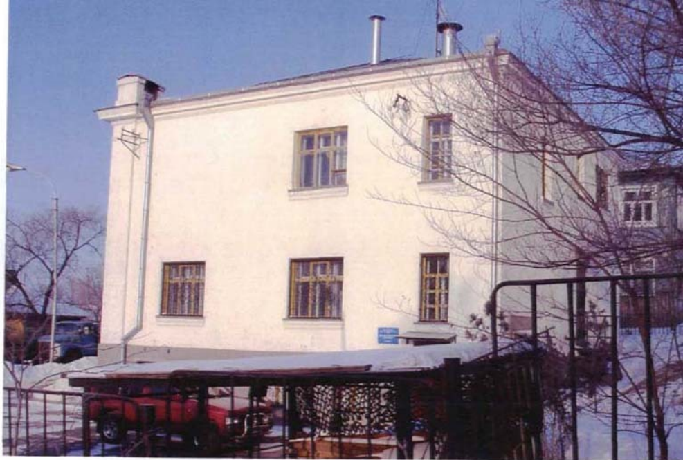
г. Хабаровск, ул. Кавказская, 22. Дом жилой Д.А. Языкова, до 1912. Юго-восточный фасад. Фото Янкевич М.К. 2005 г.
