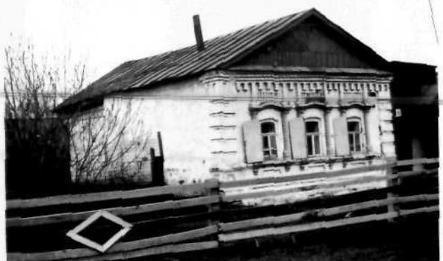
I-этажный дом состоит из двух частей: передней деревянной, обложенной кирпичом, квадратной в плане и задней, кирпичной, более узкой, прямоугольной в плане, которые покрыты одной 2-скатной железной крышей. Главный 3-оконный фасад обращен на запад. Лучковые проемы обрамляются полуколонками, несущими лучковый сандрик. Окна имеют железные ставни. Под окнами проходит тяга и устроены ниши. Над окнами - поребрики. Венчающий карниз украшен сухариками. Углы дома рустованы.
