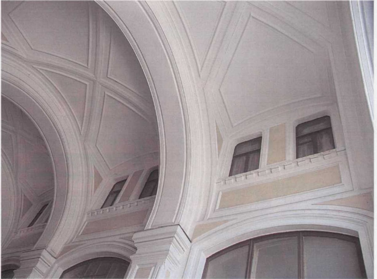
10. Оформление проездной арки вдоль Хрустального переулка.
