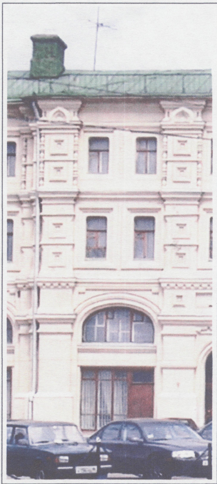
Фото №10. Рядовой фрагмент южного фасада.
