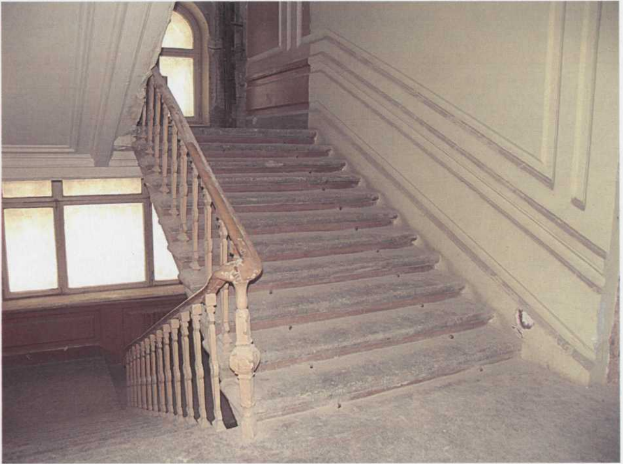
33. 3-й этаж. Лестница в юго-западной части главного корпуса по Красной площади.
