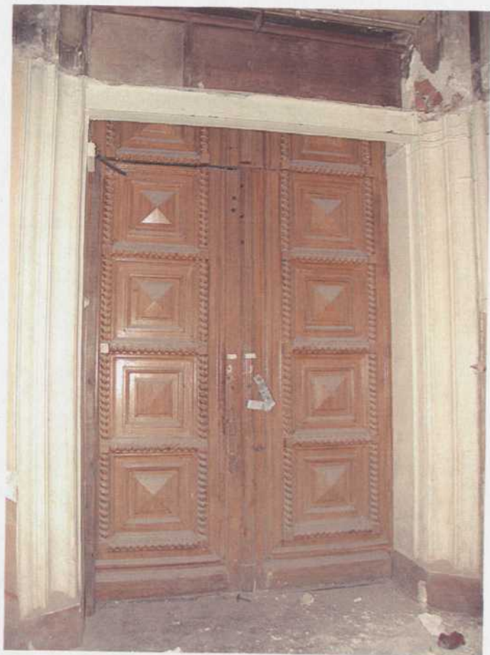
49. 3-й этаж. Лестница в восточной угловой части главного корпуса.
