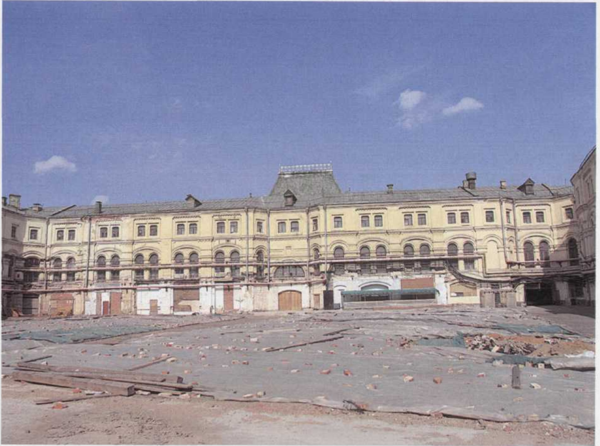
6. Дворовый фасад корпуса вдоль улицы Ильинка. Вид с юга.
