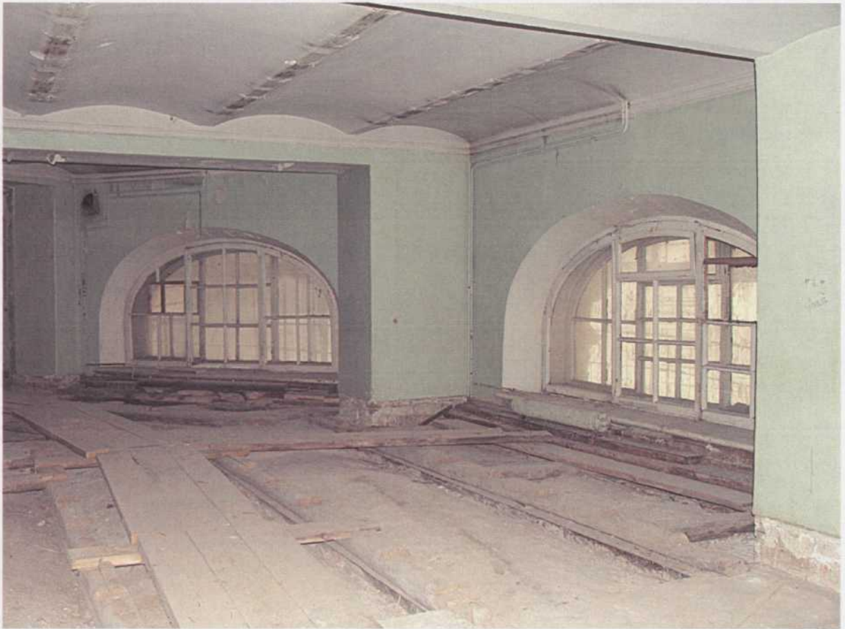
29. Антресоли. Юго-восточное угловое помещение главного корпуса.
