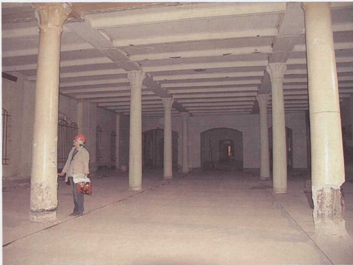
21. 1-й этаж. Помещение в главном корпусе по улице Ильинка.
