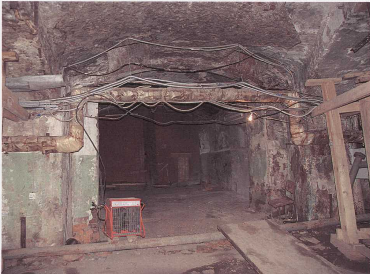
17. Выезд из подвала на улицу Варварка.
