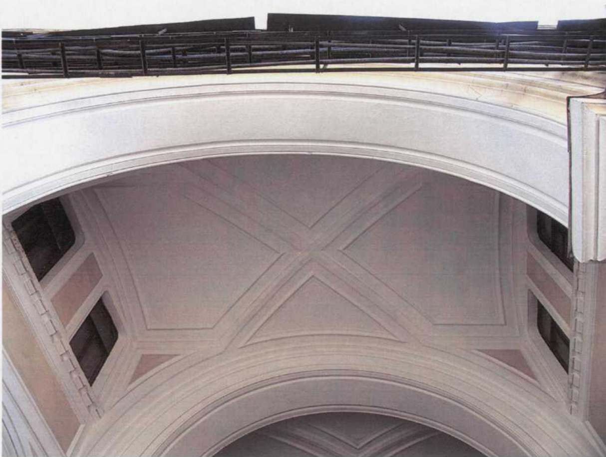
9. Оформление проездной арки корпуса вдоль Хрустального переулка.
