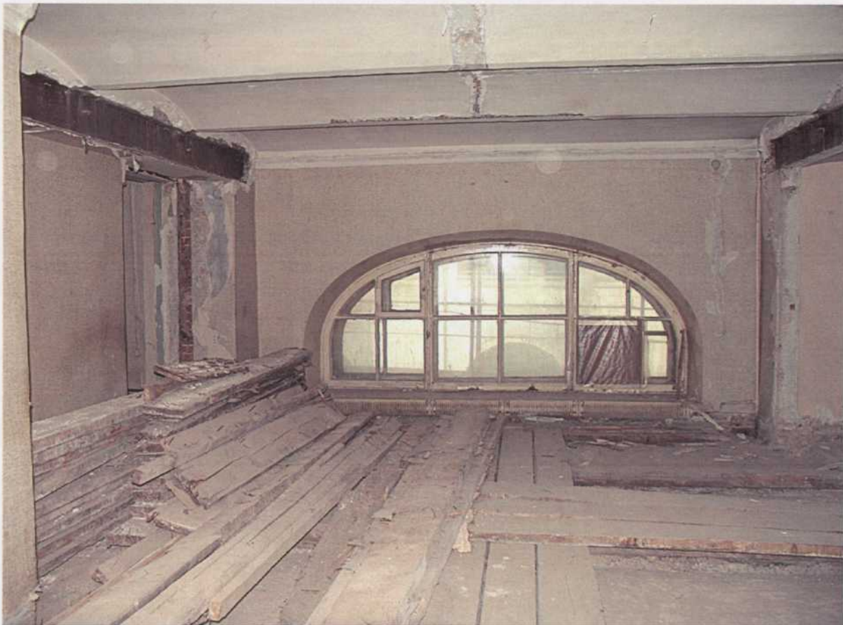
30. 2-й этаж. Одно из помещений главного корпуса по Хрустальному переулку.
