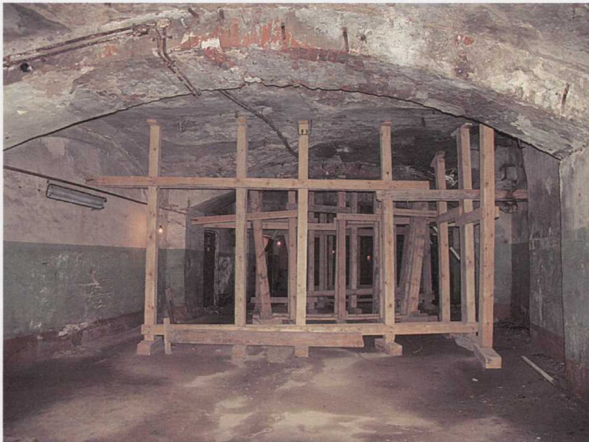
15. Коридор подвала под двором вдоль главного корпуса по Хрустальному переулку.
