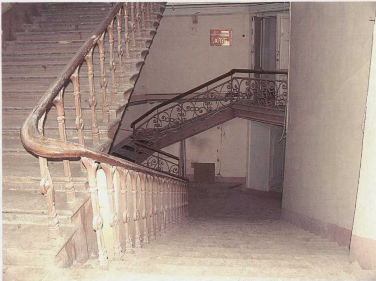
34. 3-й этаж. Угловая северо-западная парадная лестница.
