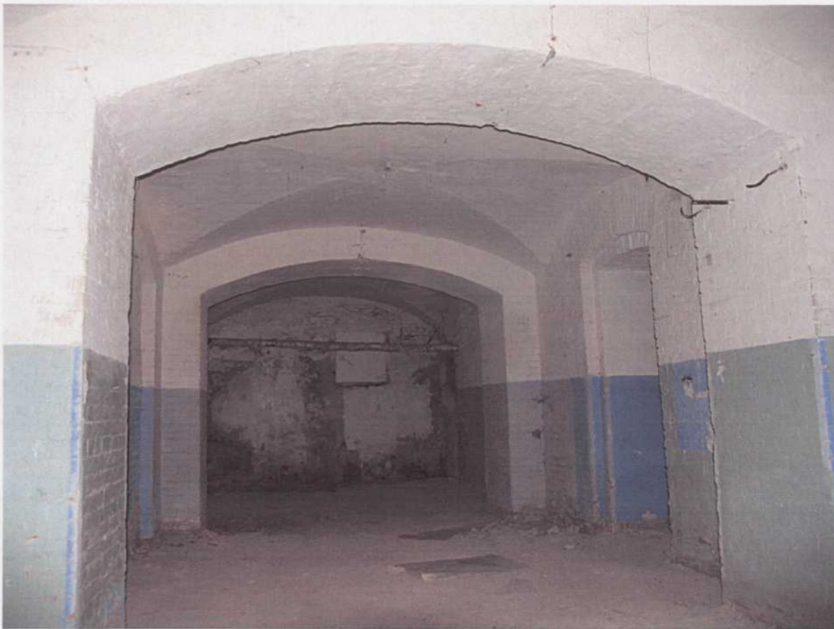
16. Одно из помещений подвала под главным корпусом по Хрустальному переулку.
