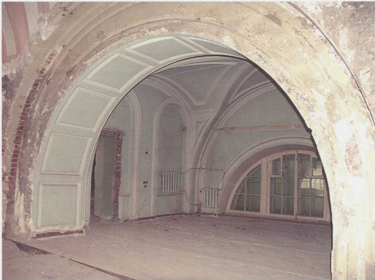
39. 3-й этаж. Одно из помещений главного корпуса по улице Ильинка.
