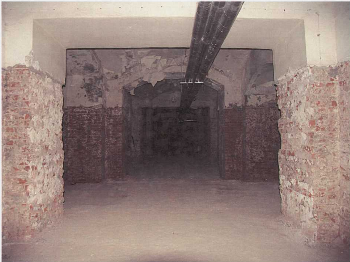
12. Помещения подвала под корпусом по улице Ильинка.
