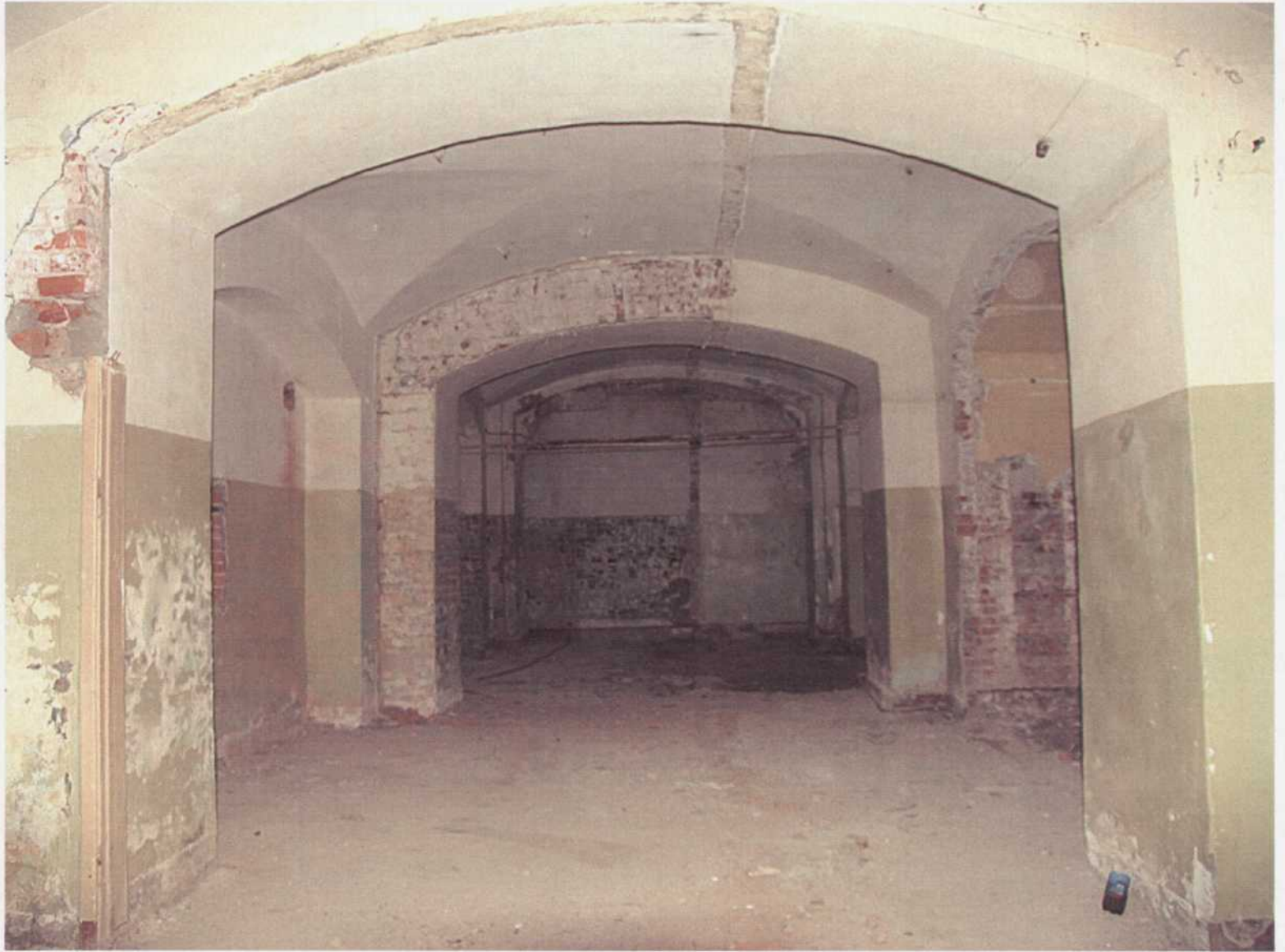
13. Одно из помещений подвала под главным корпусом по Хрустальному переулку.
