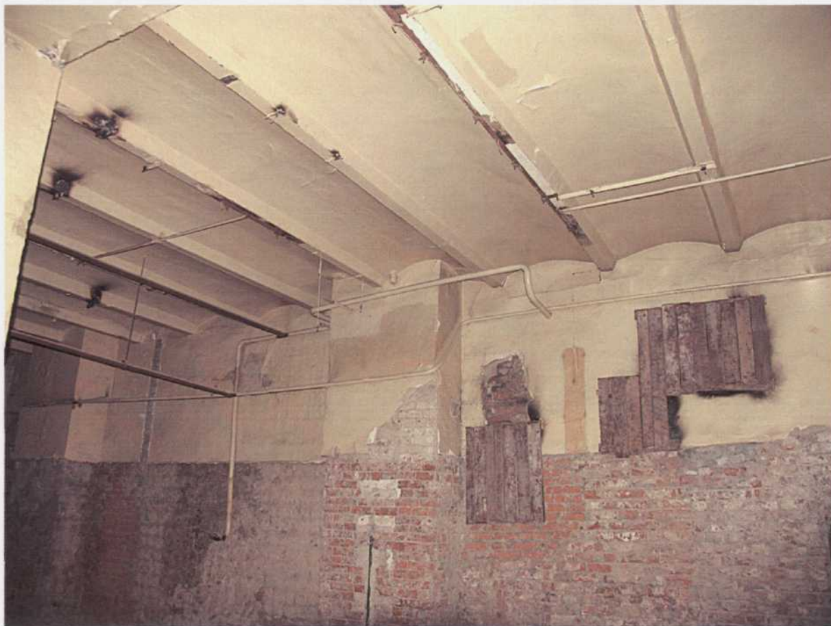
11. Перекрытия одного из помещений подвала под корпусом по улице Ильинка.
