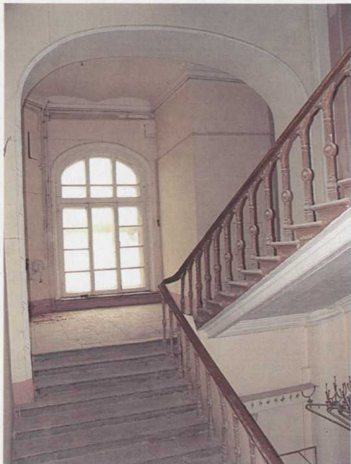
35. 3-й этаж. Угловая северо- западная лестница.
