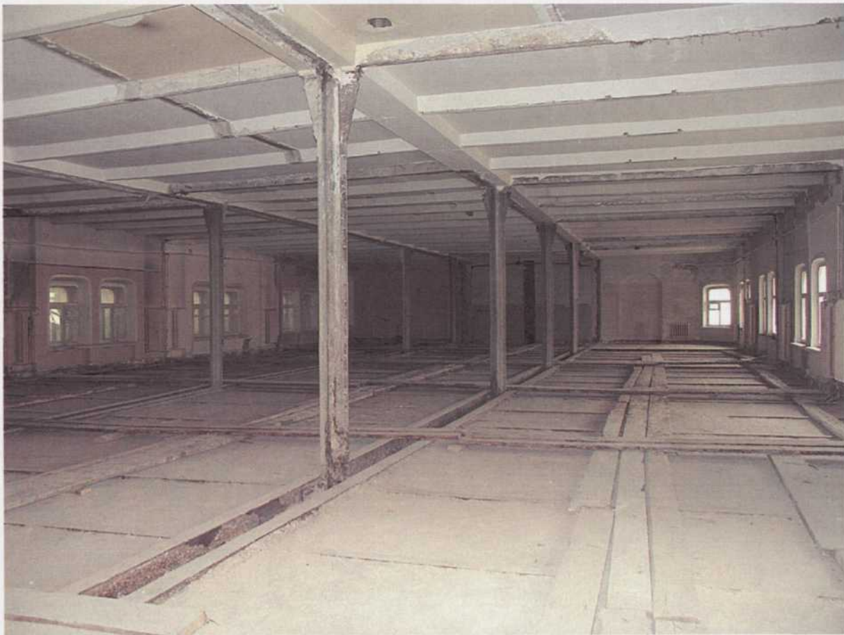
50. 4-й этаж. Одно из помещений главного корпуса по улице Ильинка.
