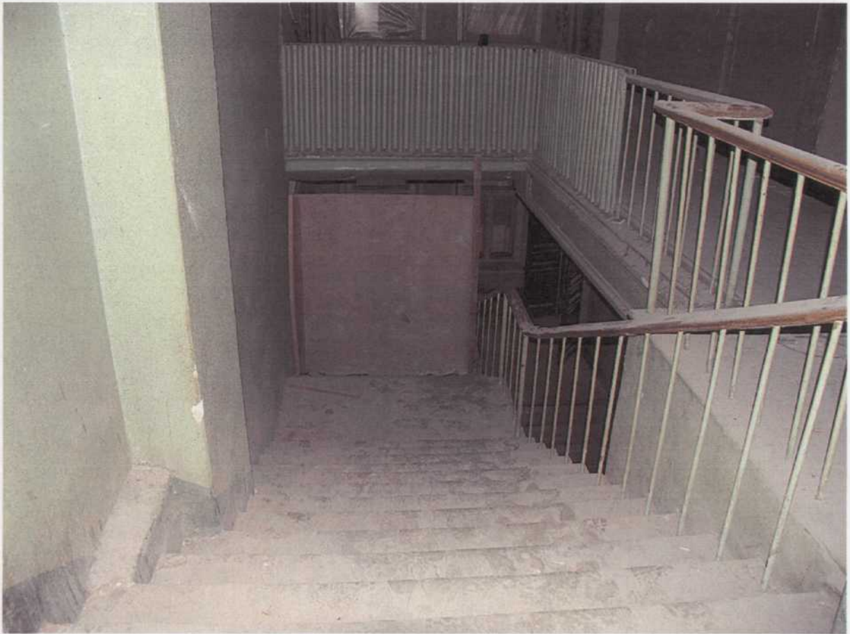
42. 3-й этаж. Лестница в восточной угловой части главного корпуса.
