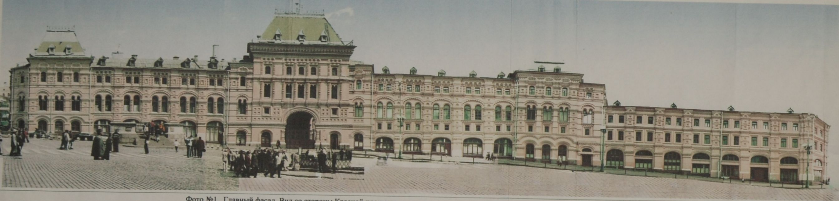
Фото №1. Главный фасад. Вид со стороны Красной площади.
