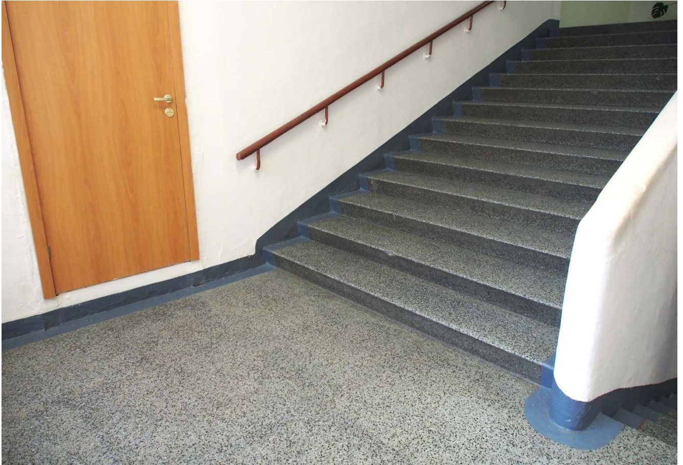
40. Бетонный пролет парадной лестницы на второй этаж.
