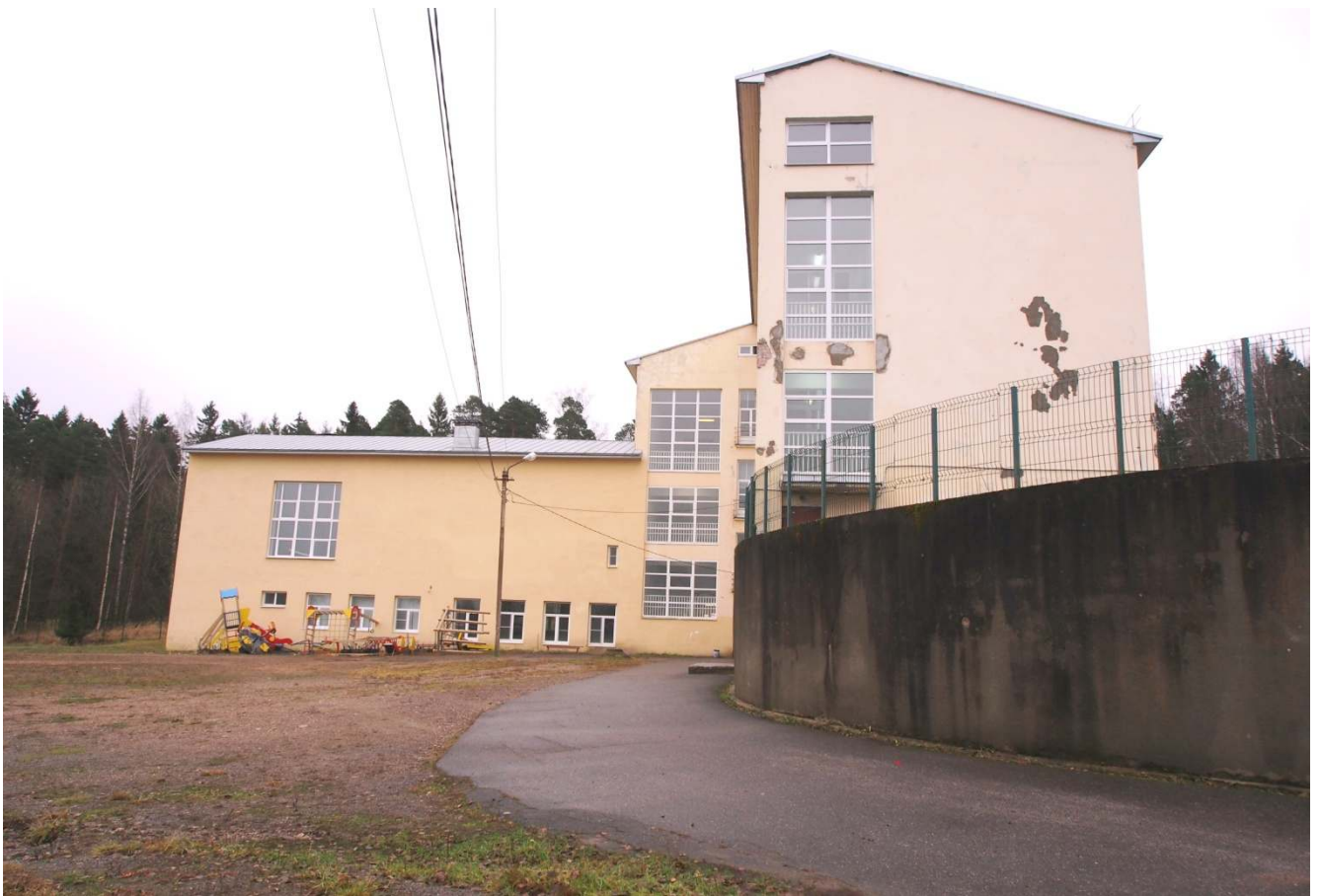
3. Вид здания с северо-запада.
