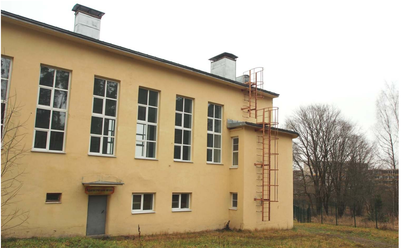
20. Ризалит северо-восточного фасада (спортивный зал).
