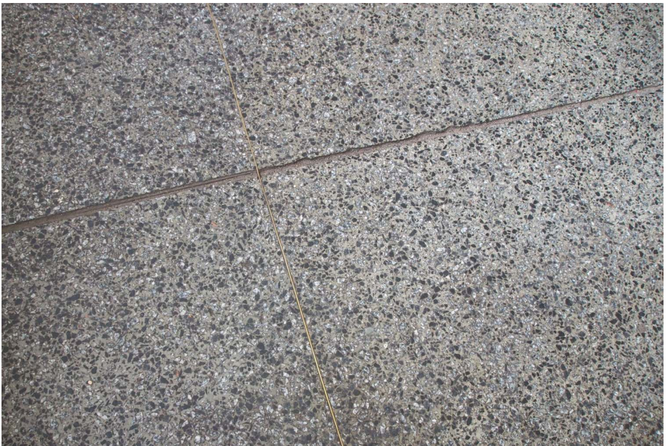
26. Выстилка пола вестибюля бетонными плитками с металлической просечкой. Фрагмент.
