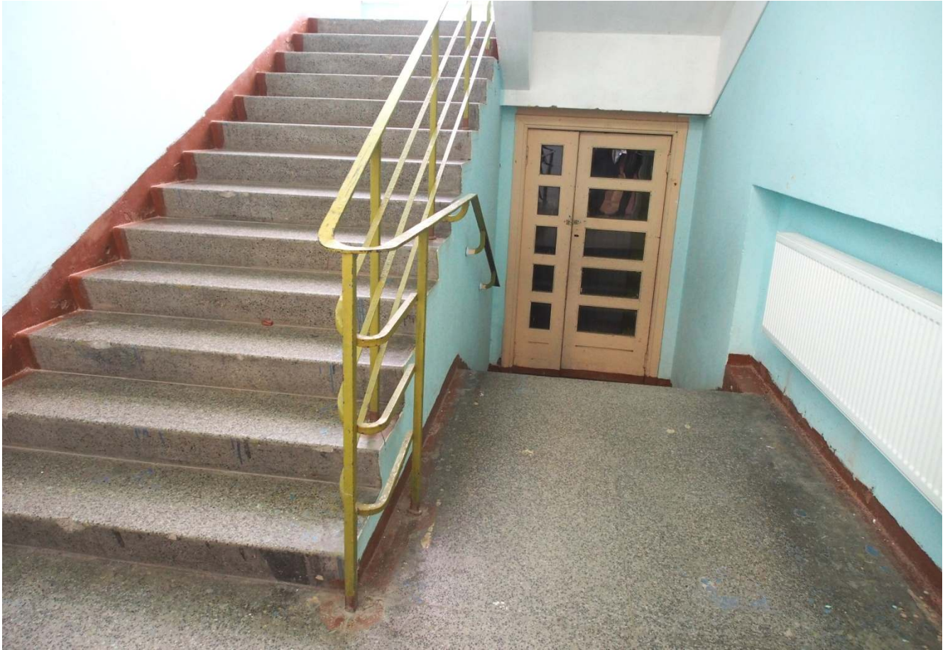
35. Бетонная лестница в северо-западном крыле здания.
