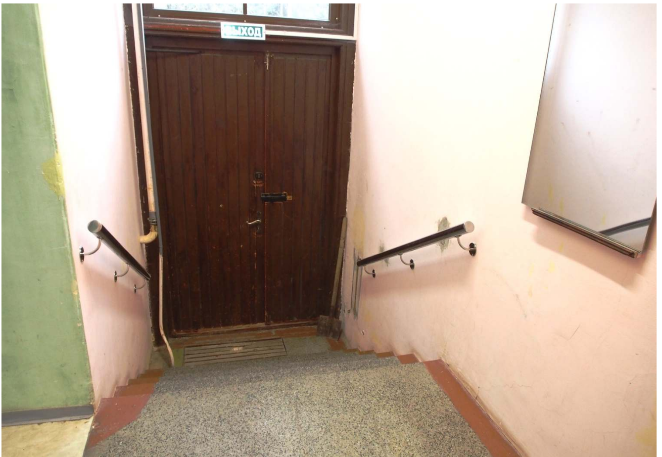
28. Бетонная лестница юго-западного запасного выхода.
