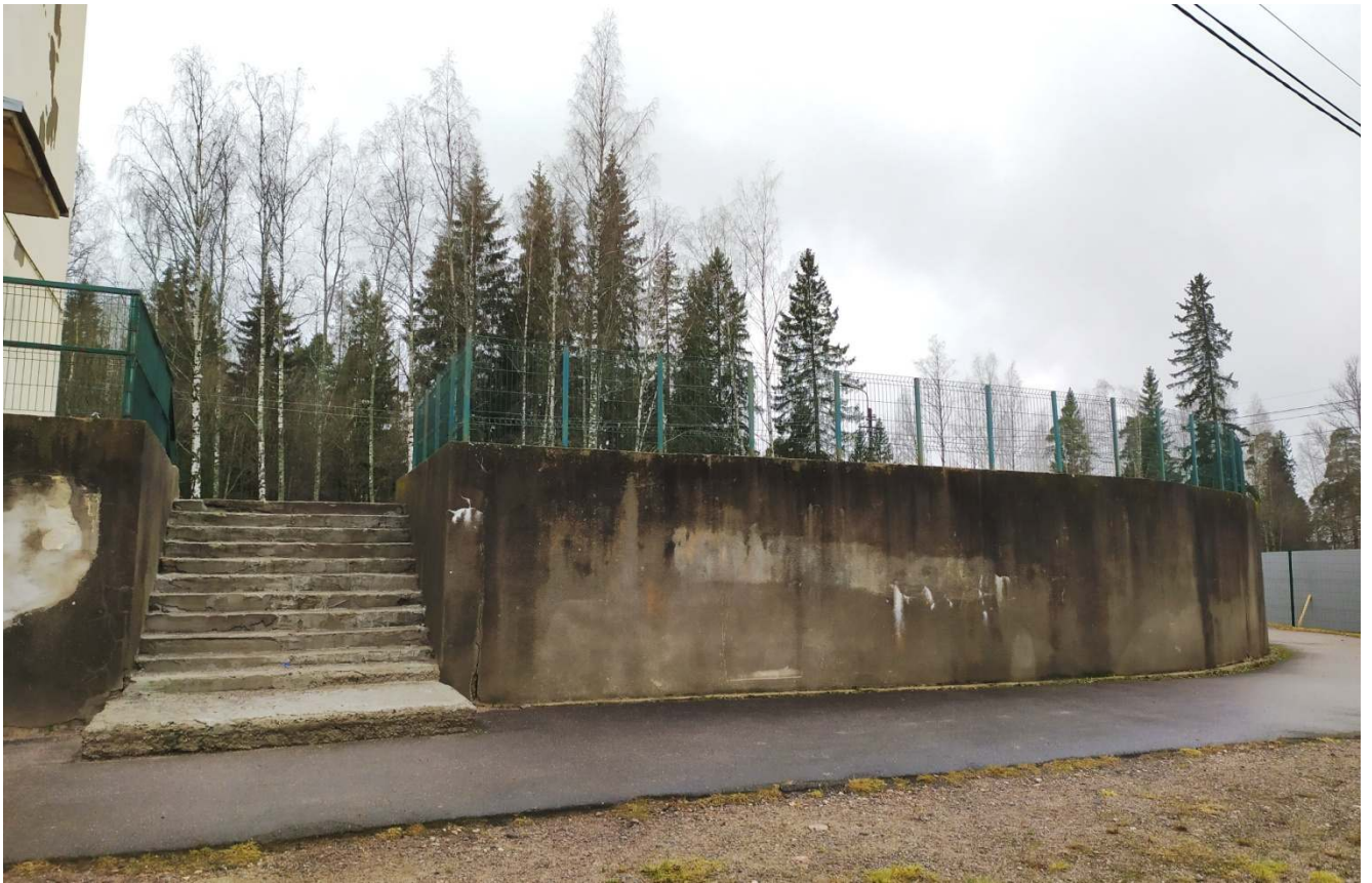
17. Бетонная подпорная стенка площадки с бетонной лестницей у северо-западного фасада.
