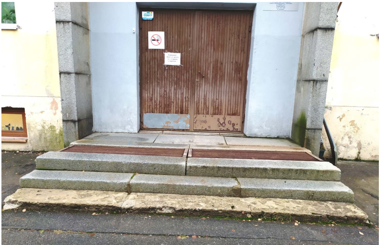
14. Фрагмент юго-западного фасада. Гранитные ступени крыльца парадного входа.
