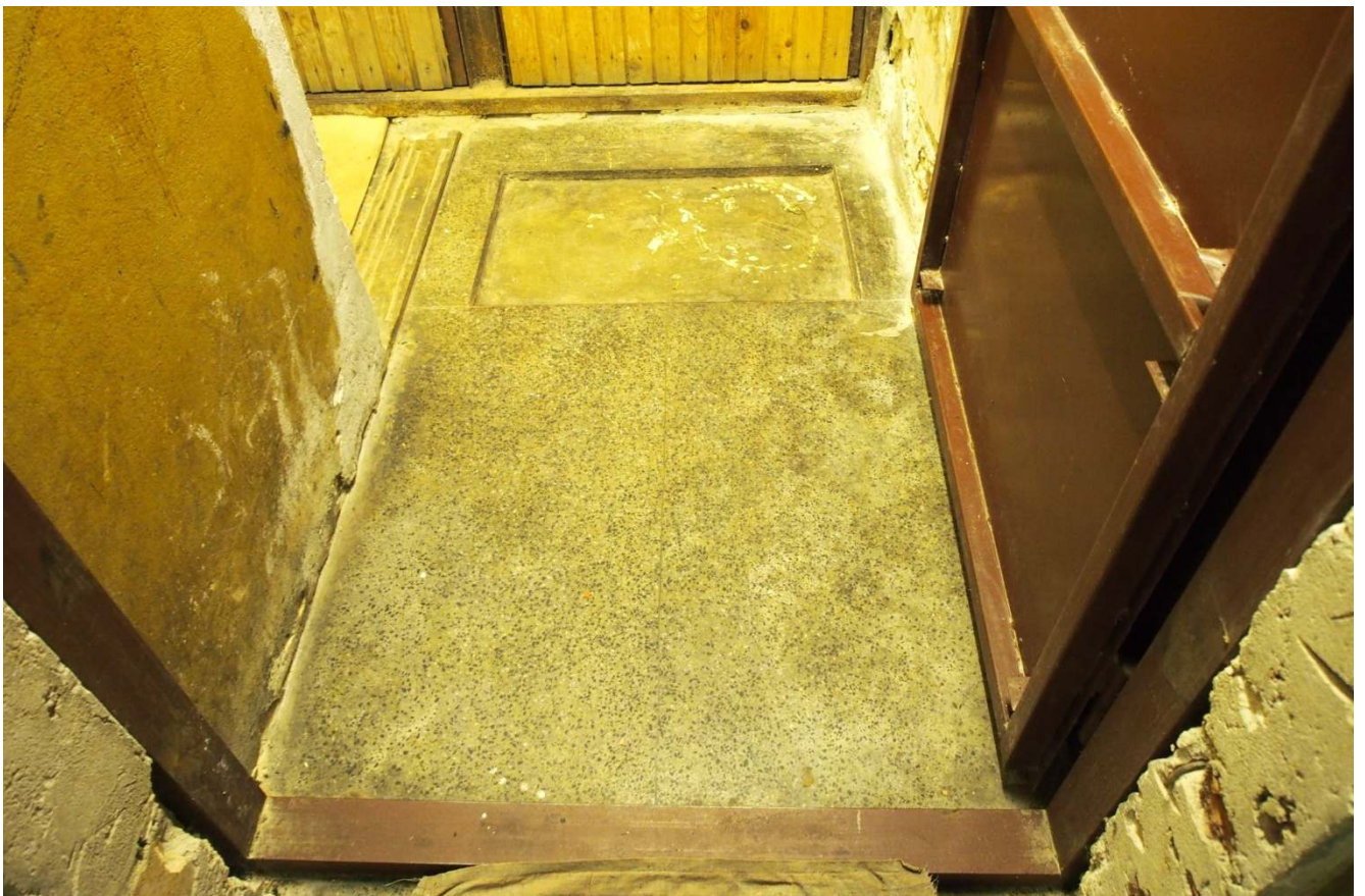
34. Наливной бетонный пол с каменной крошкой у северо-восточного запасного выхода.
