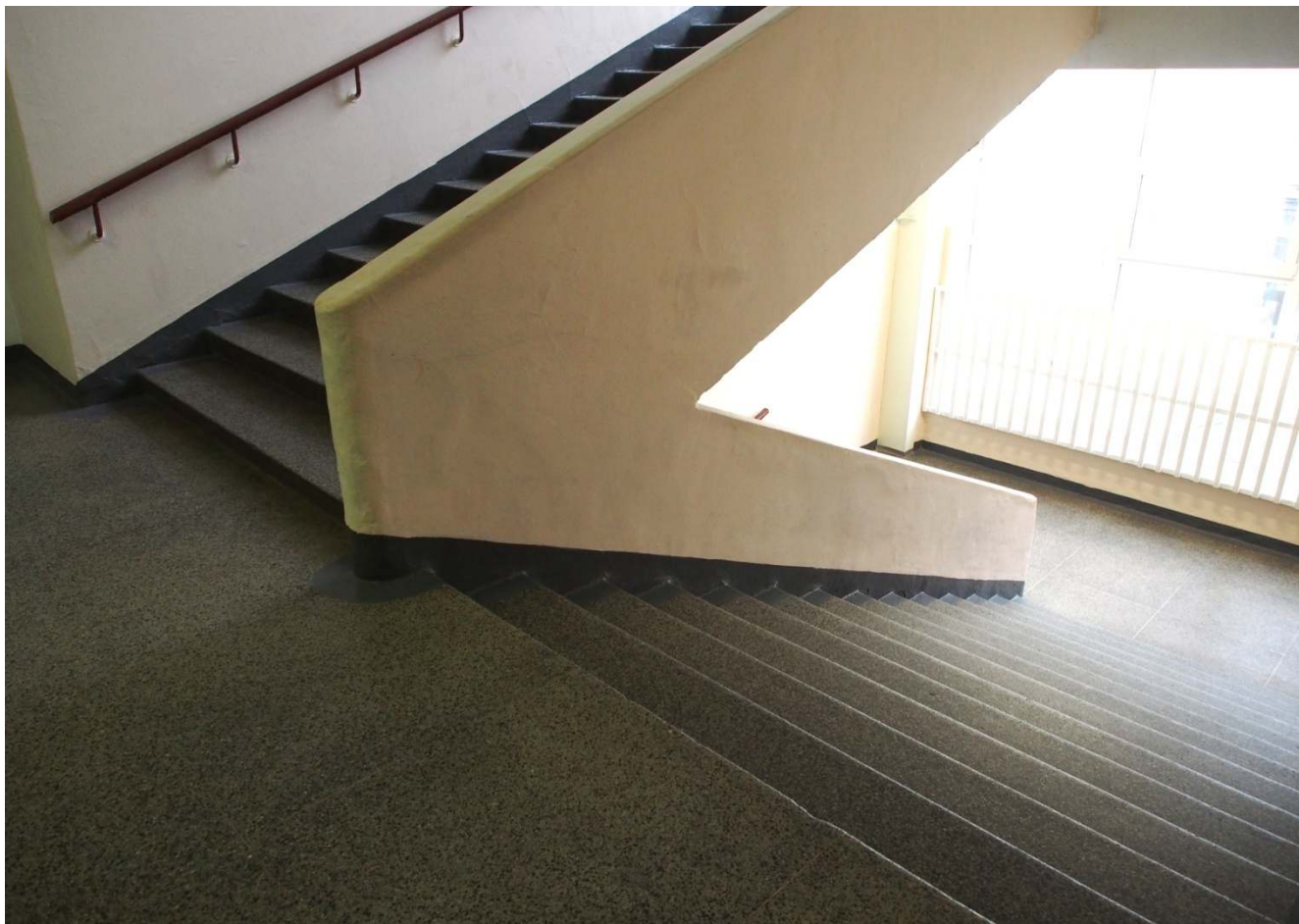
41. Бетонное ограждение парадной лестницы.
