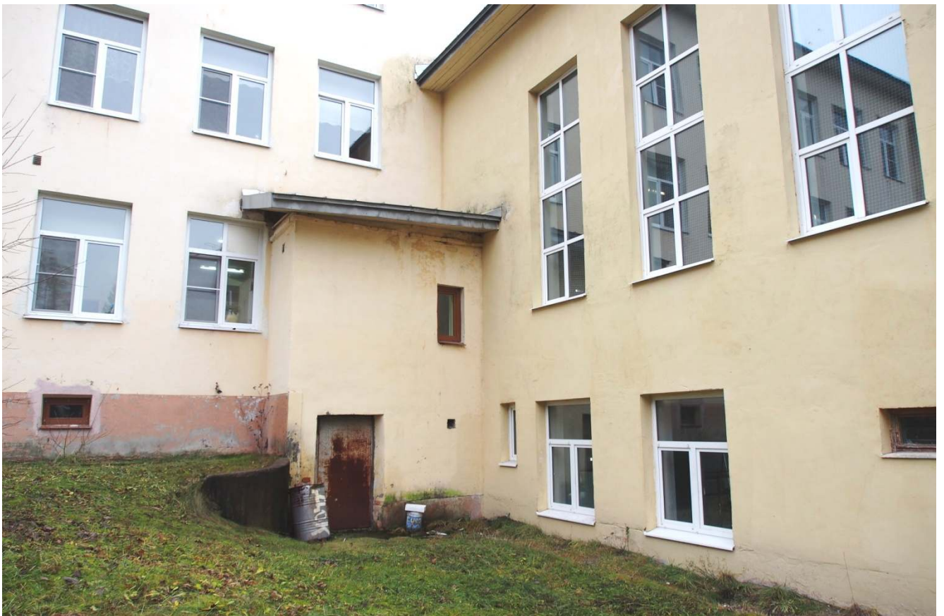
22. Фрагмент северо-восточного фасада. Запасной выход.
