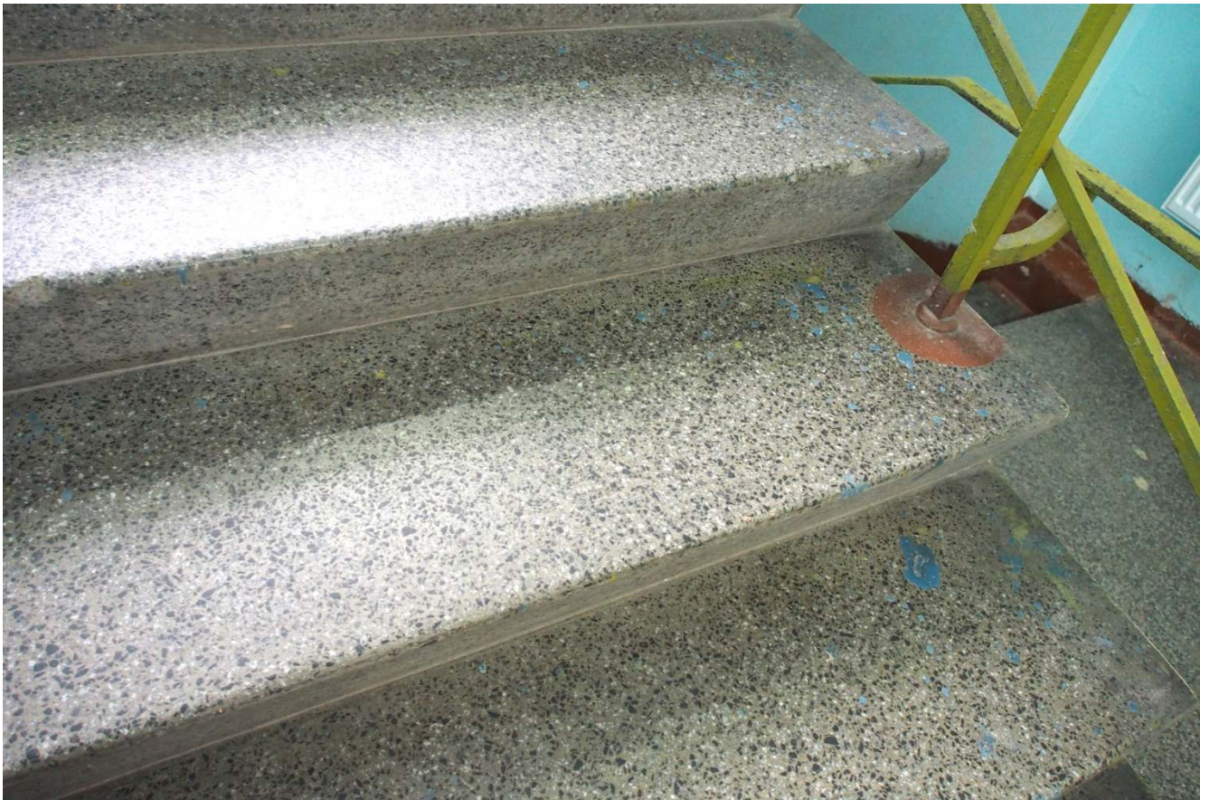
36. Бетонная лестница в северо-западном крыле здания. Фрагмент.
