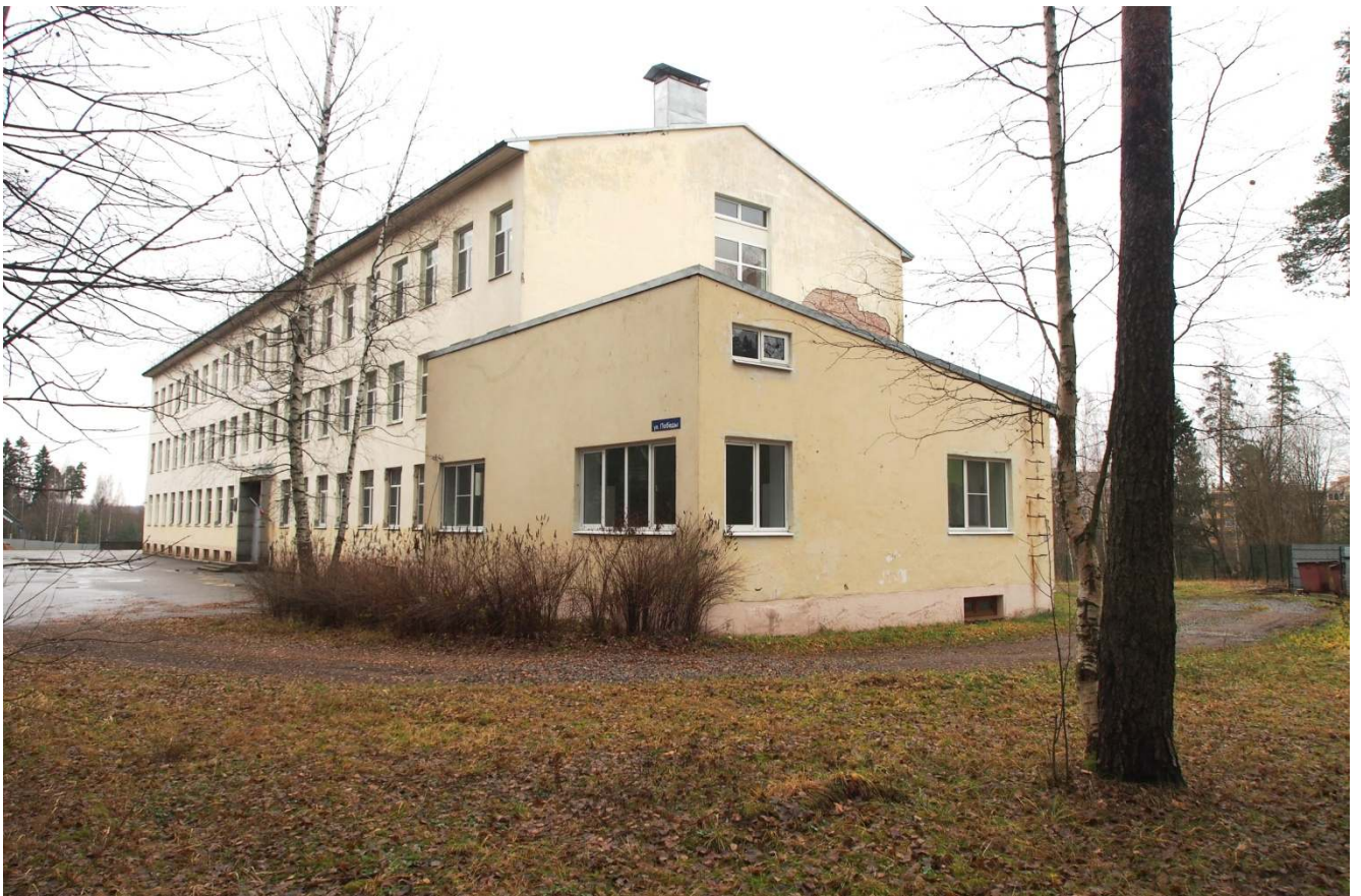
10. Вид здания с юга.
