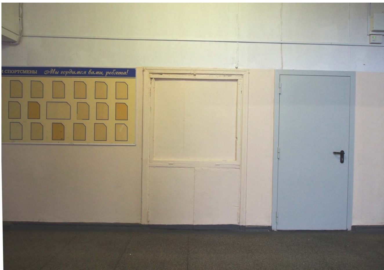
42. Лестничная площадка 1 этажа.
