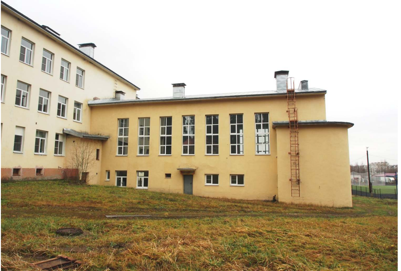
7. Вид здания с юго-востока.
