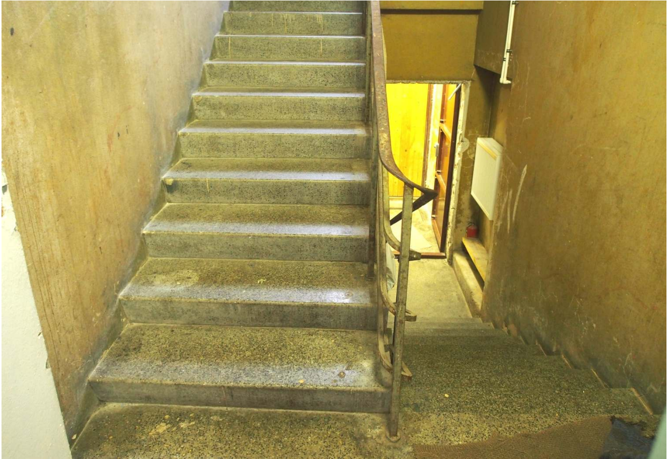
33. Бетонная служебная лестница в юго-восточном крыле здания.
