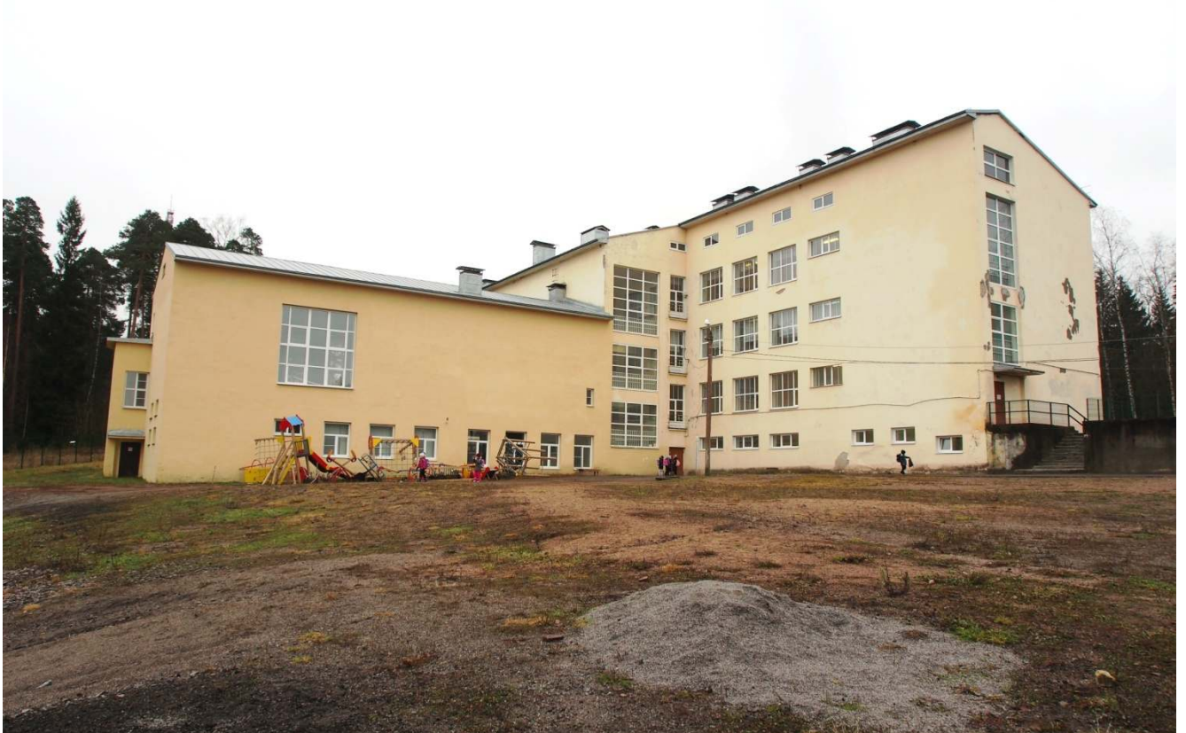
4. Общий вид здания с севера.
