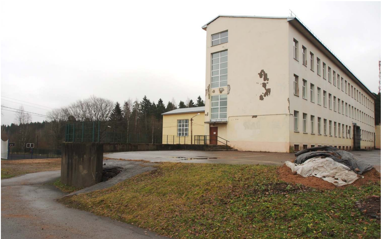
2. Северо-западный фасад здания.
