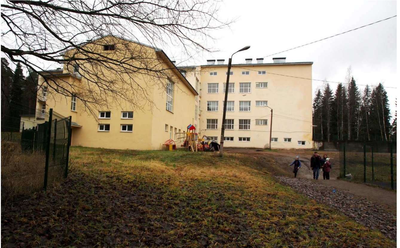
5. Вид здания с северо-востока.
