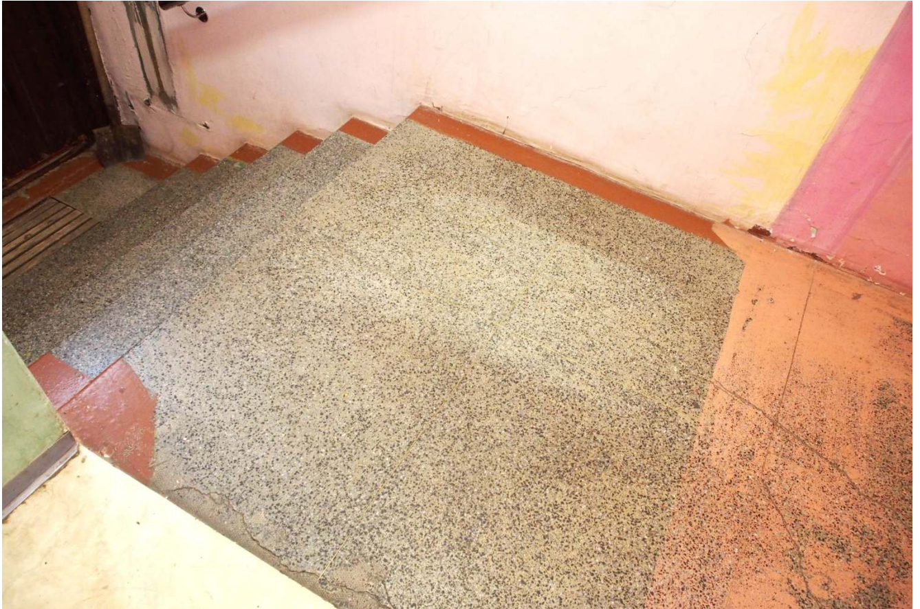
29. Выстилка пола вестибюля бетонными плитками с металлической просечкой в коридоре у юго-западного запасного выхода.
