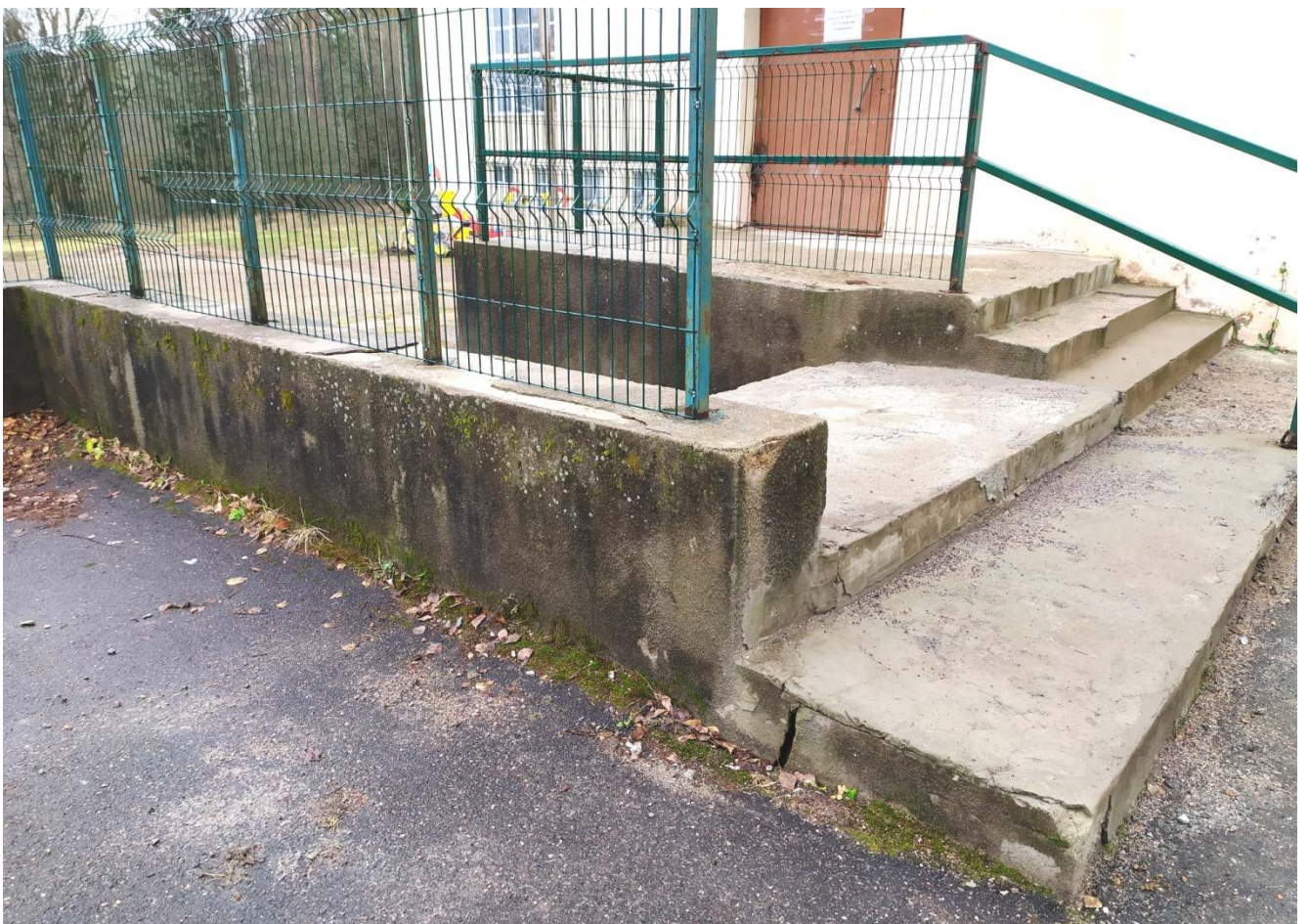
16. Бетонная лестница у запасного выхода северо-западного фасада.
