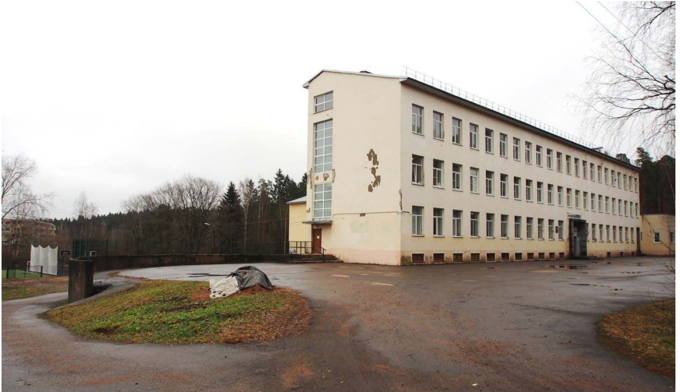
1. Общий вид здания с запада.
