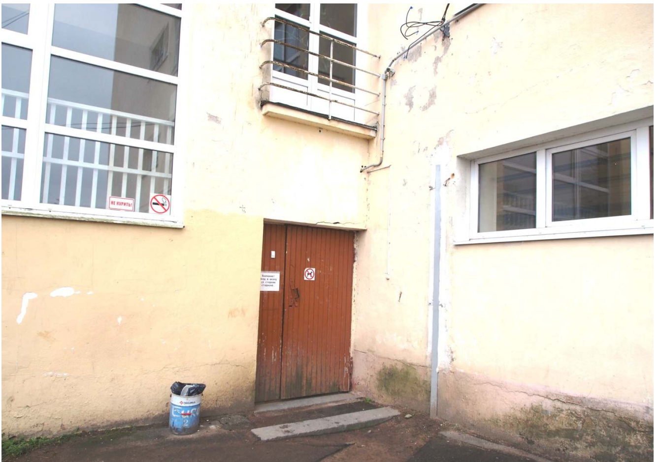
18. Фрагмент северо-восточного фасада. Вход в здание школы.
