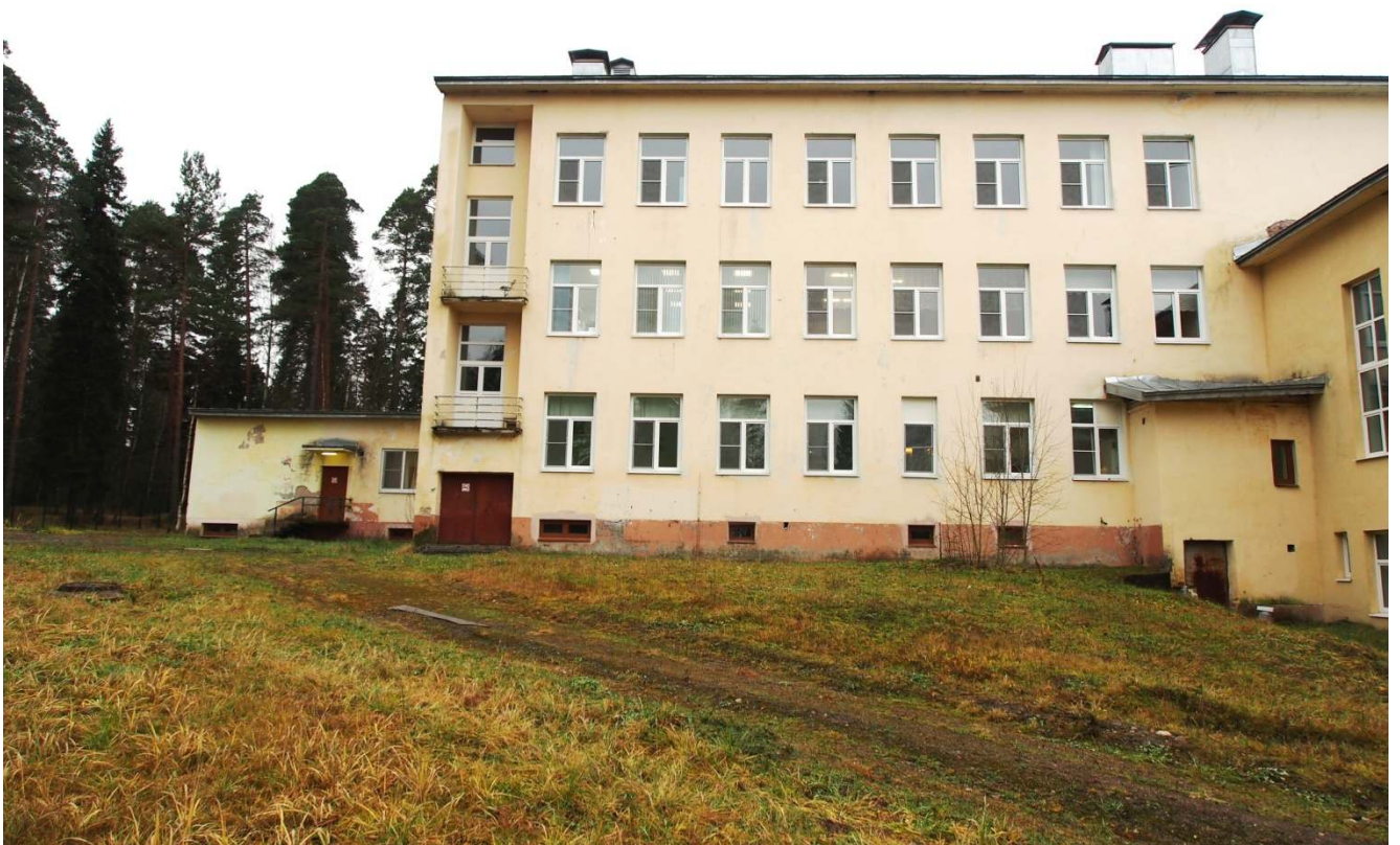
8. Вид здания с востока.
