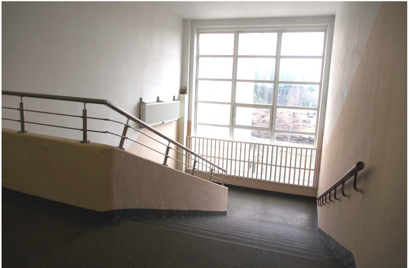
45. Лестничный пролет на 3 этаж.
