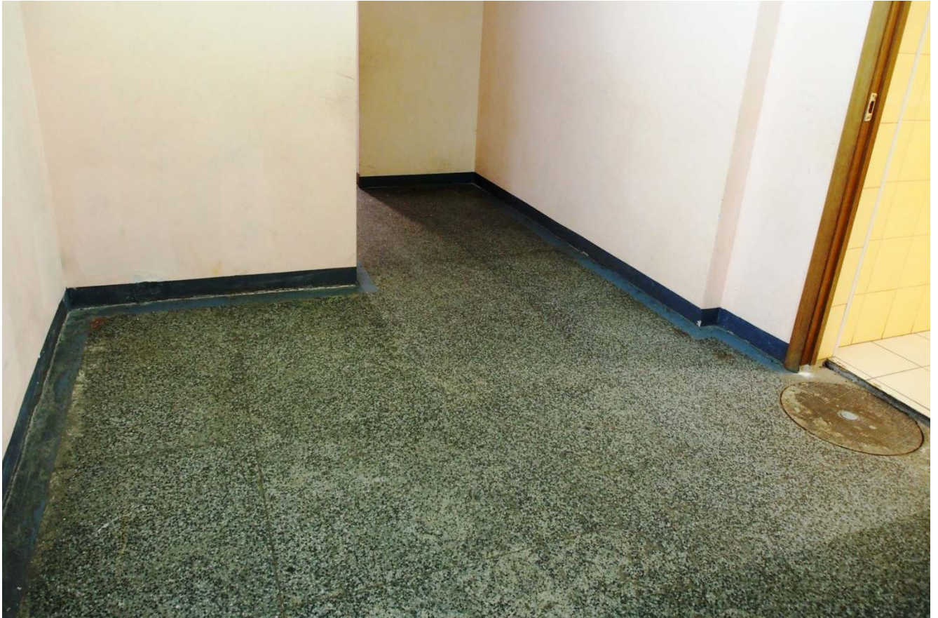
27. Выстилка пола вестибюля бетонными плитками с металлической просечкой в коридоре цокольного этажа.
