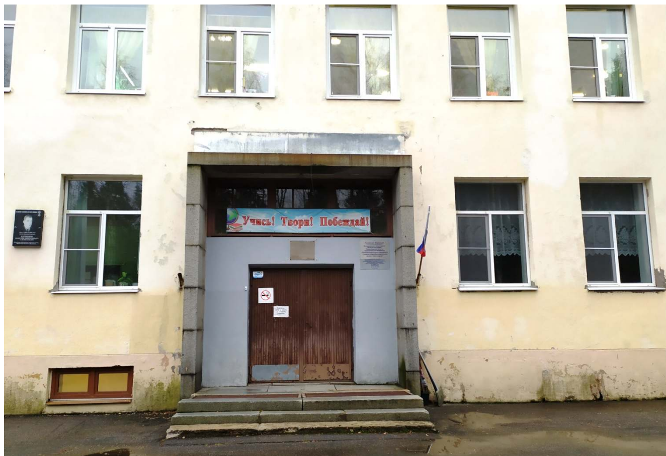
12. Фрагмент юго-западного фасада. Парадный вход с гранитным порталом.
