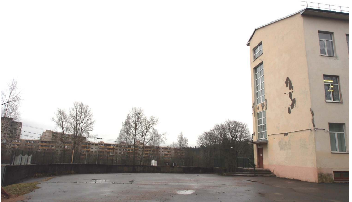
15. Заасфальтированная площадка с бетонной подпорной стенкой у северо-западного фасада.
