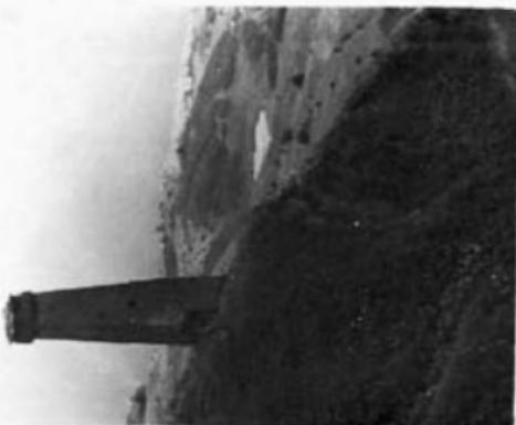
Боевая башня Шула стоит высоко в горах, на крутом склоне обрывистого утеса, над каньоном небольшой речки, впадающей в Дере-ахк. Размеры в плане 5,0 x 5,25 м, толщина стен в основании 1,5 м. Высота башни по западной стене около 20 м. Вход на западной стене. Башня имеет нетрадиционные конструкции /межникуниси/ они более широкие/ и покрытие /оно более плоское/. Стены сложены из огромных каменных блоков. На башне обнаружен петроглиф.
