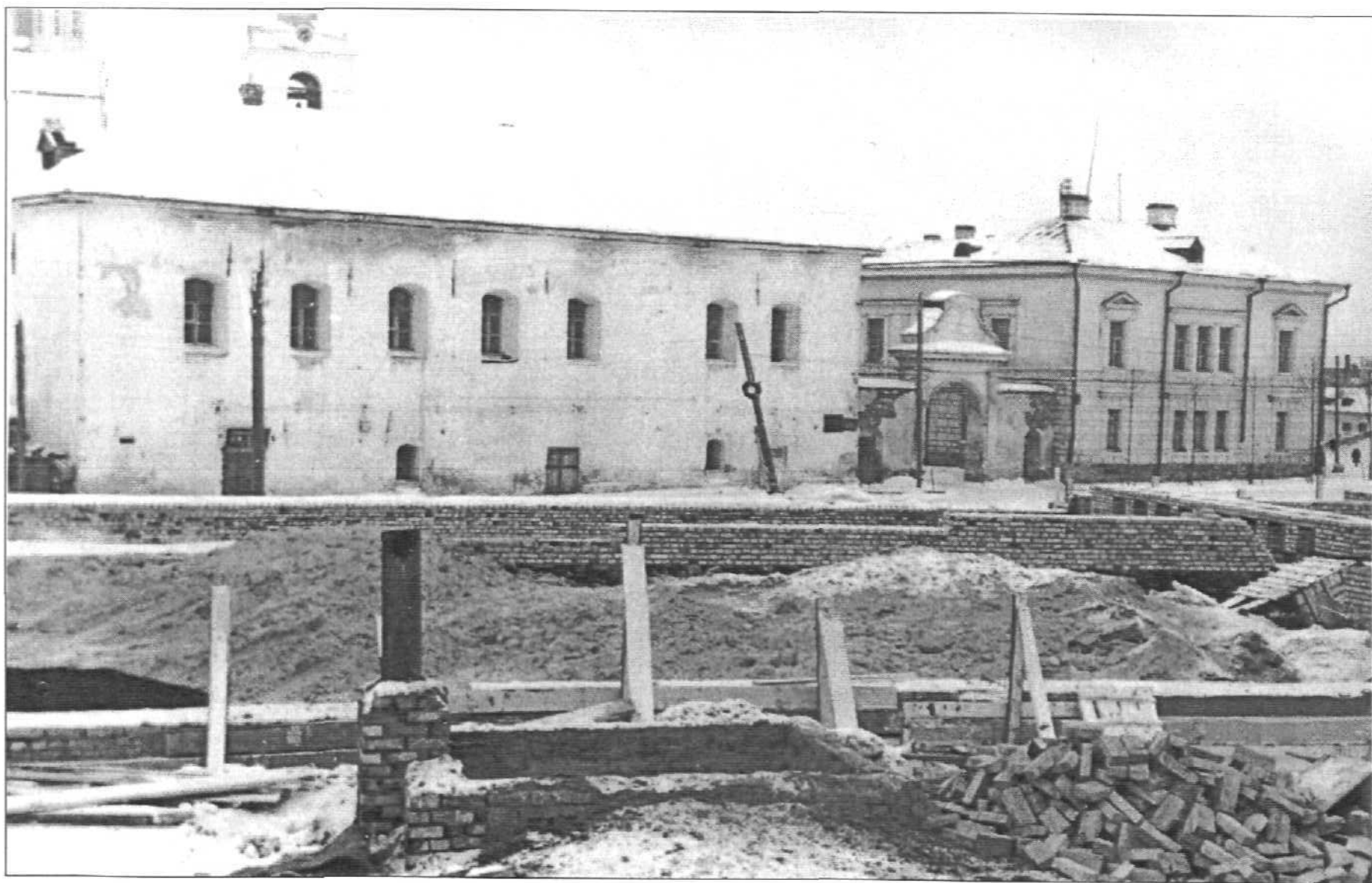
32. Вид на Приказную палату и здание Консистории от строящегося здания кинотеатра «Октябрь». Снимок 1958 года.
