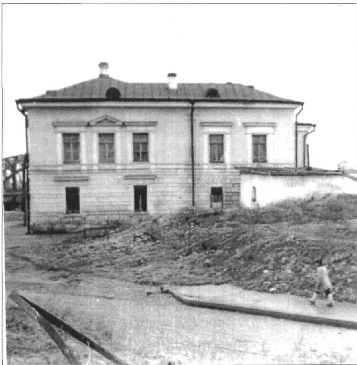
30. Северо-восточный боковой фасад здания Консистории. Снимок 1952 года.
