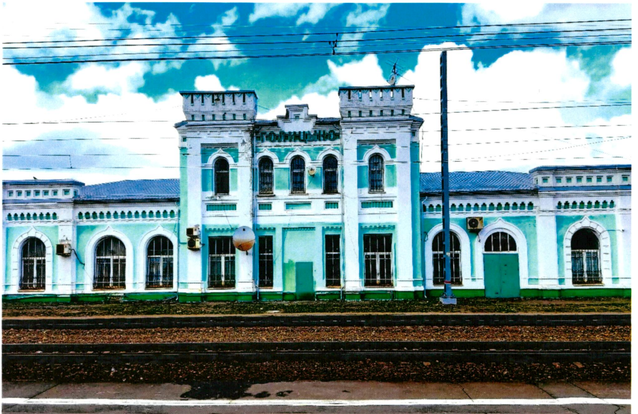
3. Главный восточный фасад
