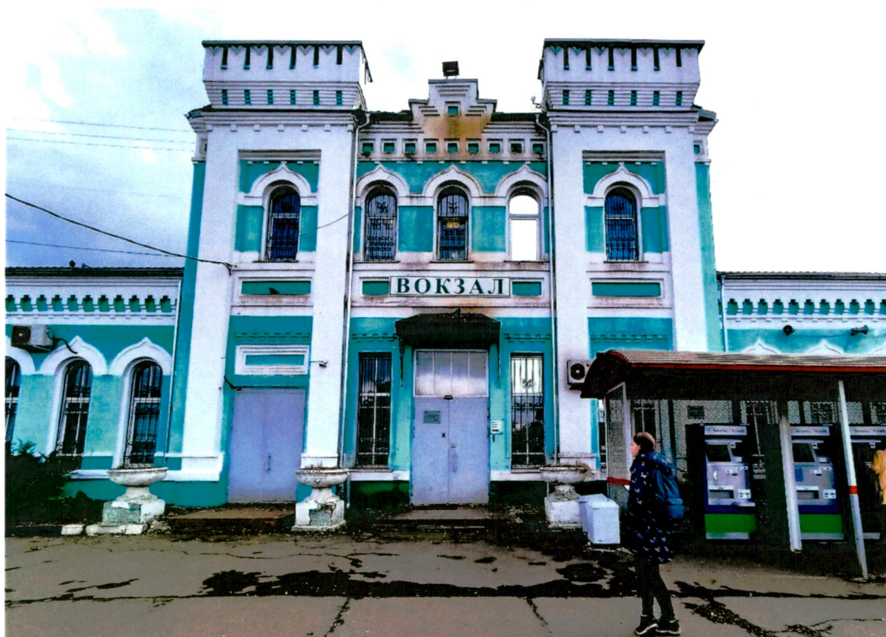
8. Центральная часть западного фасада.
