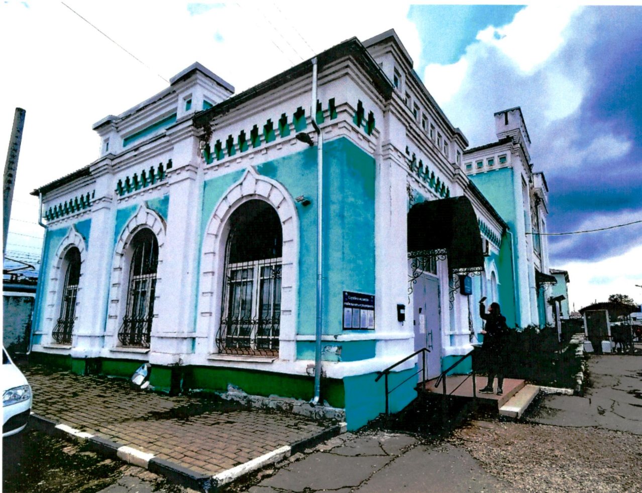
7. Северо-западный угол здания
