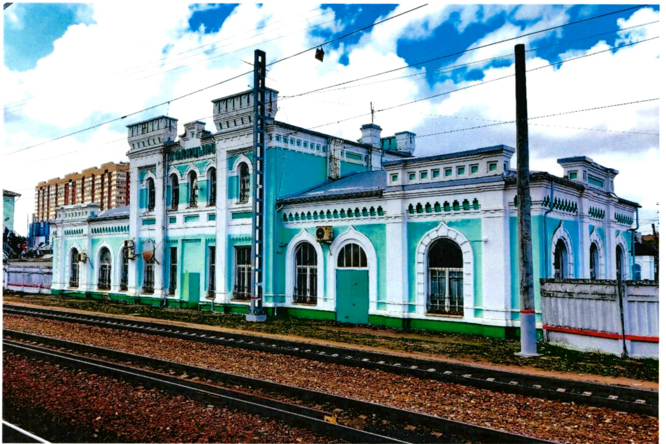
2. Общий вид с северо-востока
