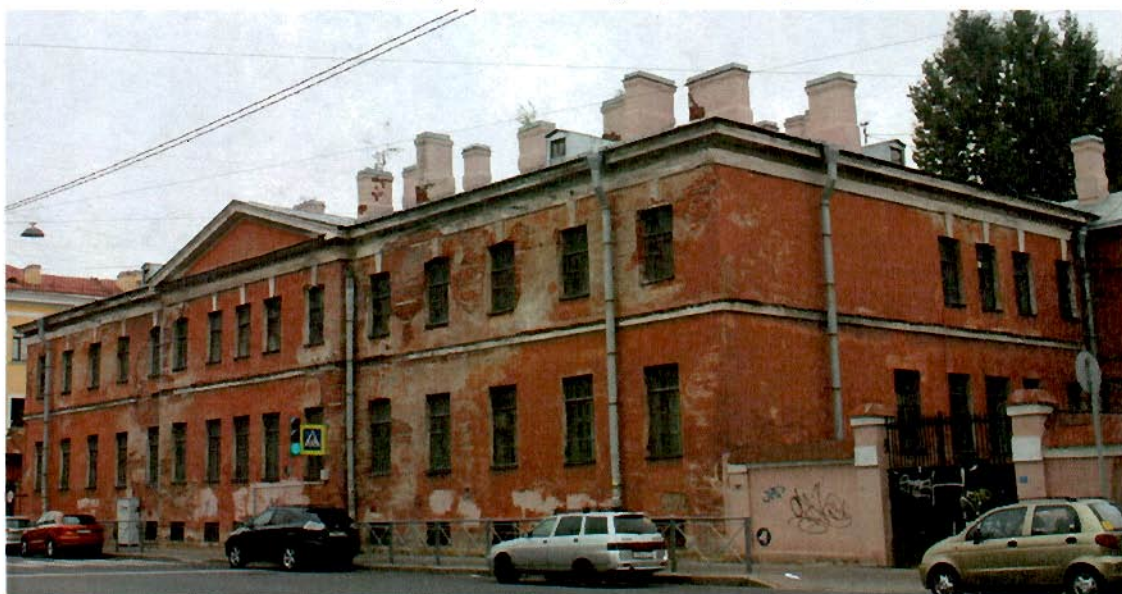
Фото №1. Лицевой фасад. Вид со стороны ул. Рузовской.
