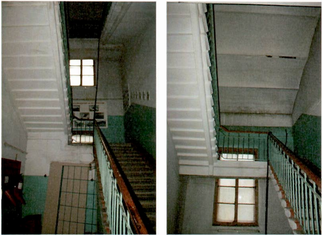
Фото №18, 19. Лестничная клетка Л-1.
