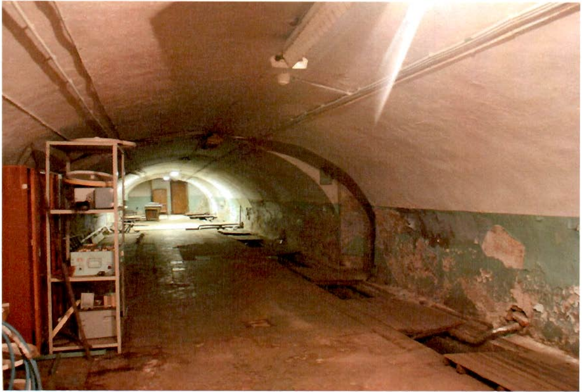
Фото № 6. Помещение 6-Н цокольного этажа.
