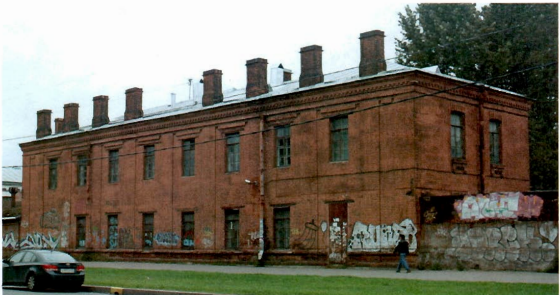
Фото №17. Северо-восточный фасад. Вид с ул. Введенского канала.
