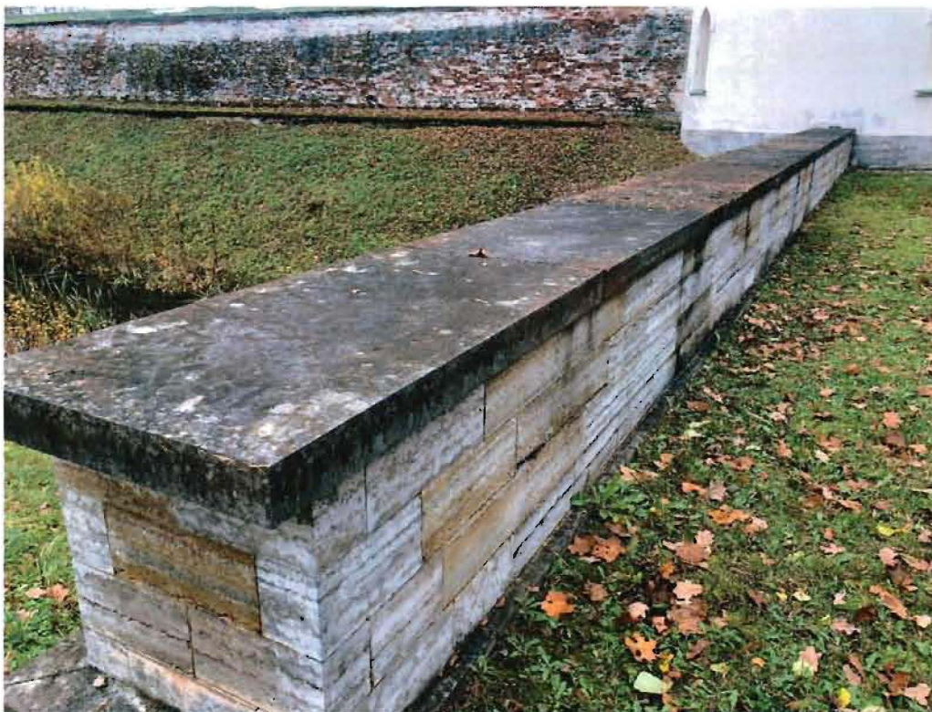
Фото № 4. Фрагмент парапета объекта культурного наследия (следы намокания, очаги биопоражения).
