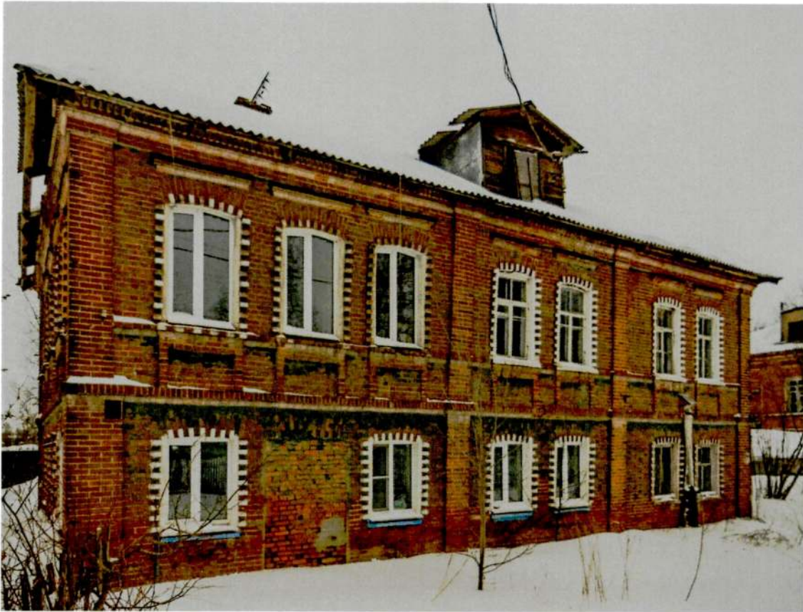
2. Южный фасад жилого дома Боборыкиных
