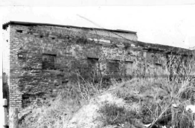
От первоначального объема кирпичного прямоугольного в плане флигеля, занимавшего южный угол двора присутственных мест, сохранилась только наружная (юго-восточная) стена, переходящая в кирпичную ограду двора, которые декорированы равномерно расположенными прямоугольными нишами с клинчатыми перемычками. Дворовая часть флигеля полностью разобрана.
