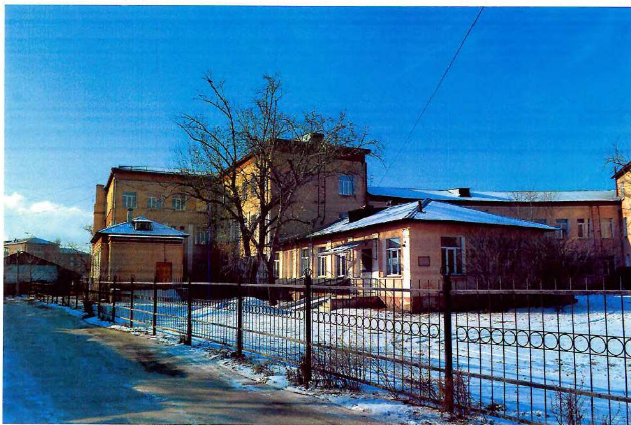
Фото 6. Фрагмент северо-восточного дворового фасада.
