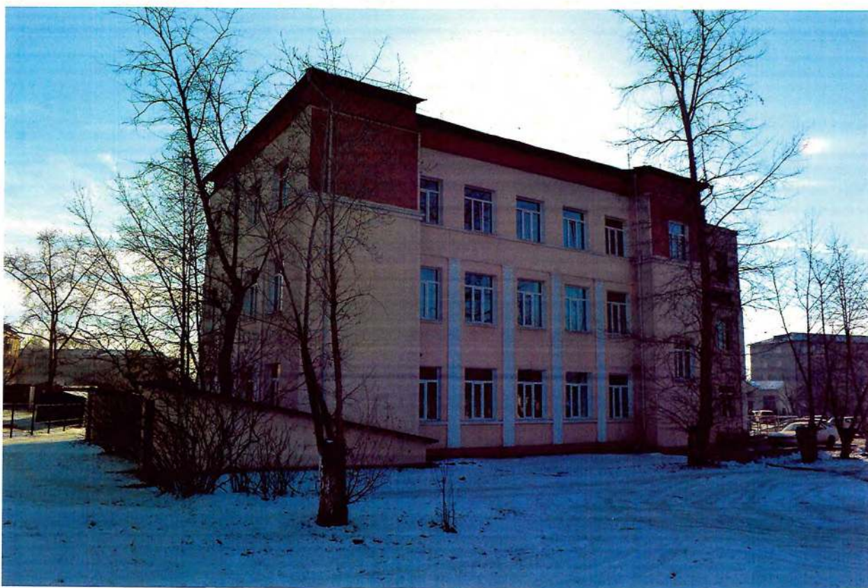
Фото 10. Северный торцевой и западный фасад.
