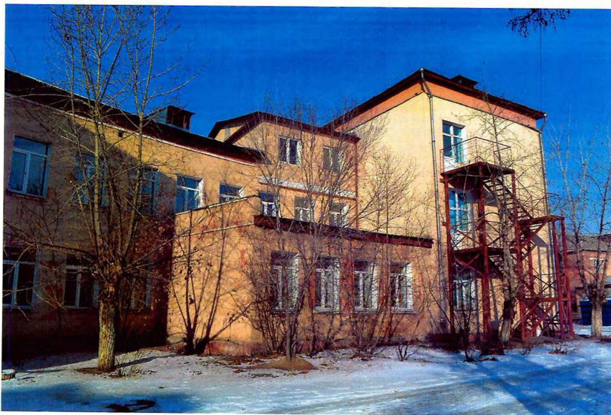
Фото 8. Фрагмент северо-восточного дворового фасада.
