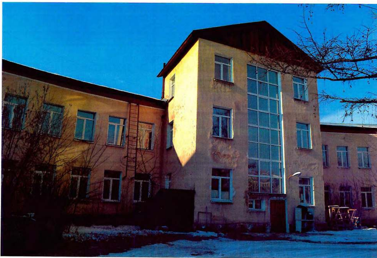
Фото 7. Фрагмент северо-восточного дворового фасада.
