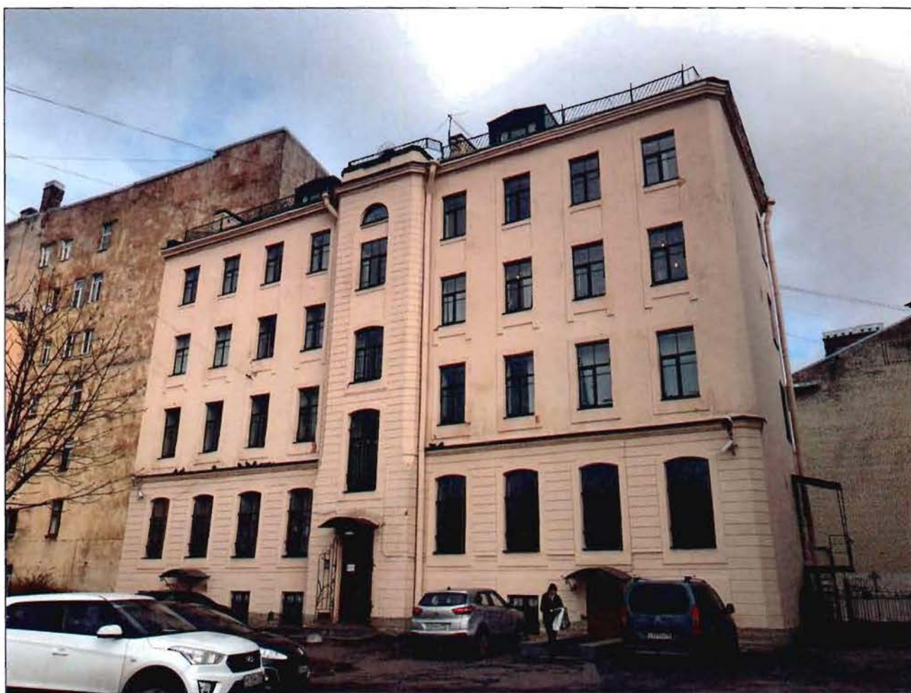
1. Юго-западный фасад. Общий вид.
