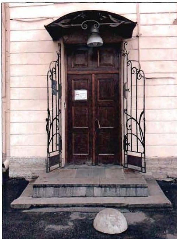
2. Главный вход. Общий вид.
