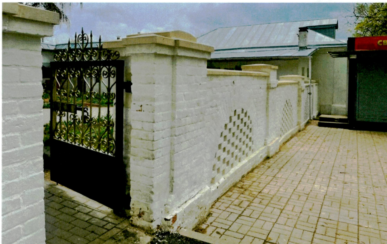
3. Южная часть западной стороны ограды с калиткой. Вид с севера
