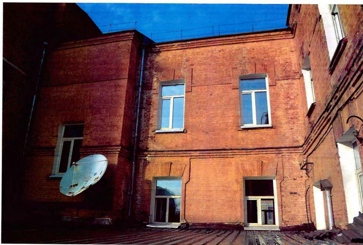
Фото 5. Дворовый южный фасад.
