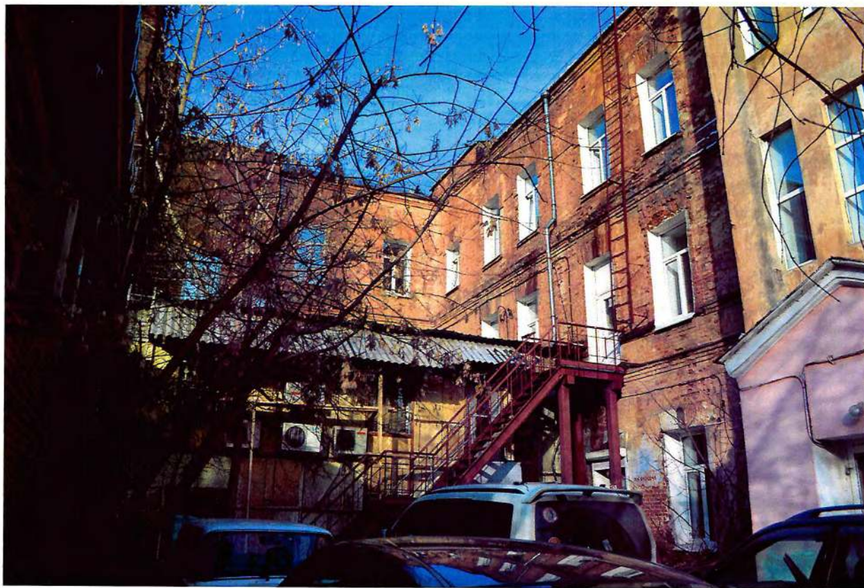
Фото 4. Дворовые южный и западный фасады.
