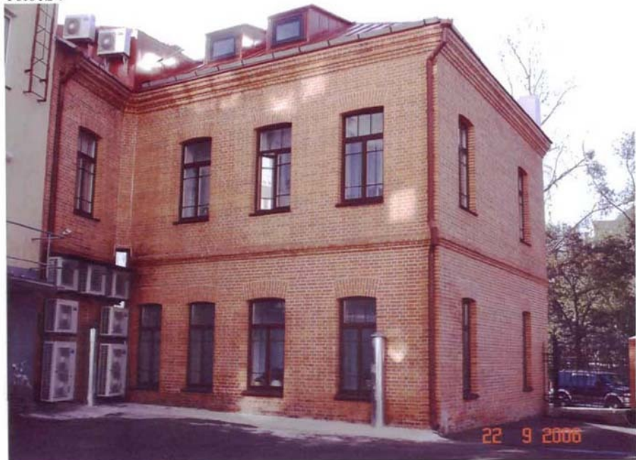
г. Хабаровск, ул. Фрунзе, 41 Дом доходный Кабатовых и Вшивковых, до 1917 г. Северо-западный фасад
