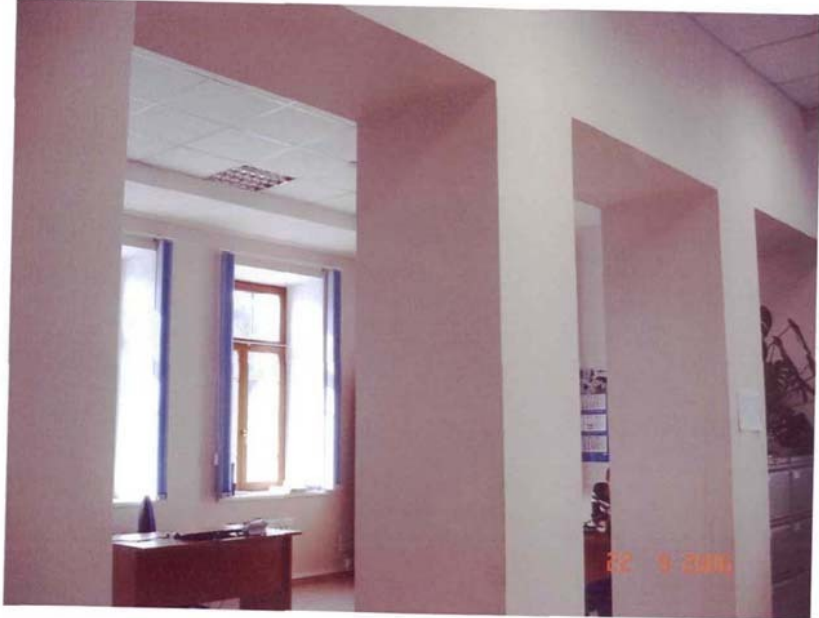
г. Хабаровск, ул. Фрунзе, 41 Дом доходный Кабатовых и Вшивковых, до 1917 г. Интерьер помещений второго этажа.
